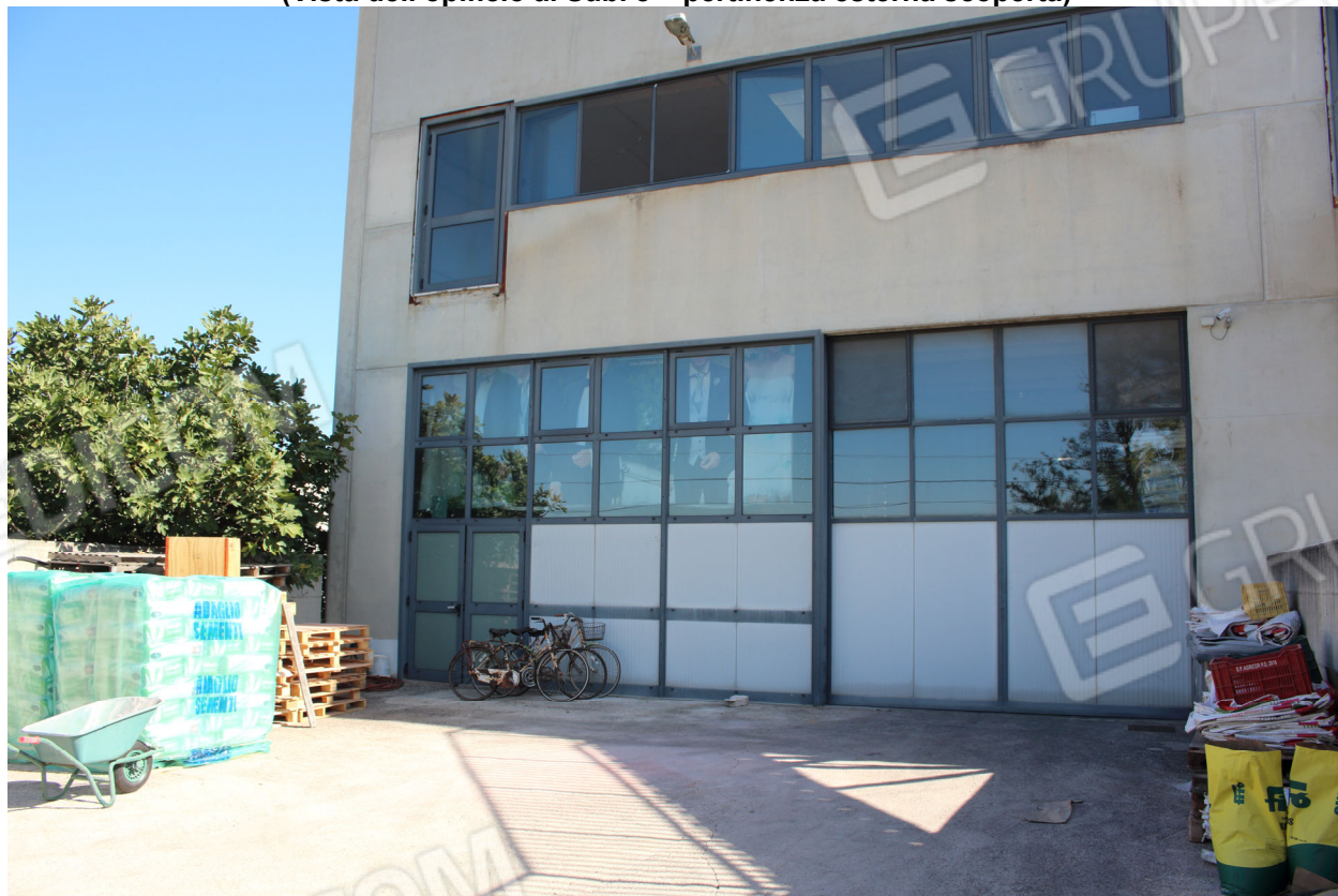
Foto 14 (Vista dell'opificio al Sub. 8 – pertinenza esterna scoperta)
