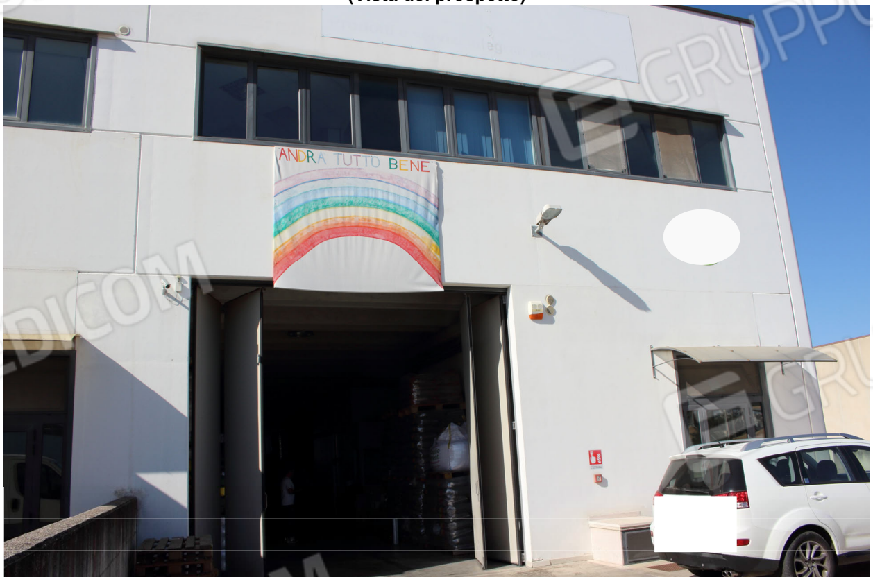
Foto 2 (Vista del prospetto)
