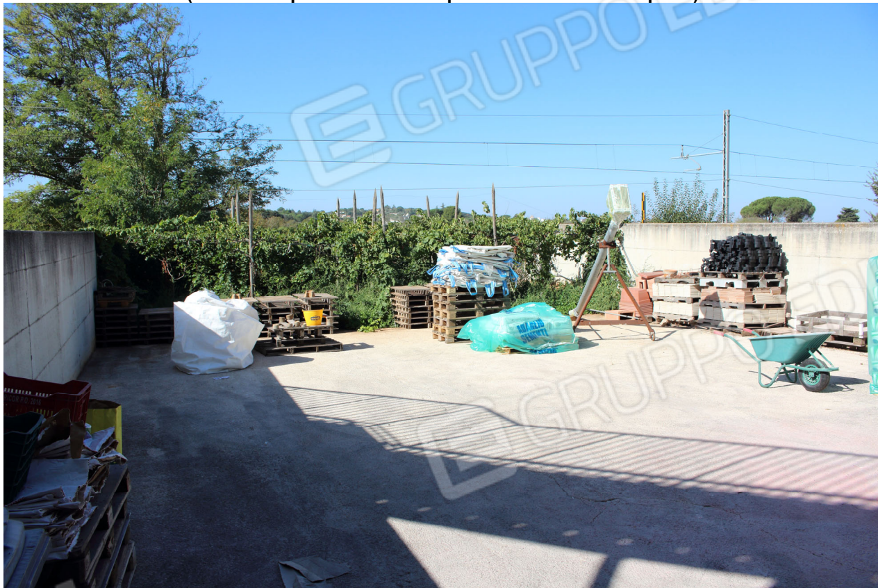
Foto 13 (Vista dell'opificio al Sub. 8 – pertinenza esterna scoperta)
