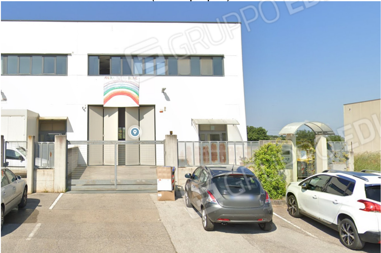
Foto 1 (Vista del prospetto)
