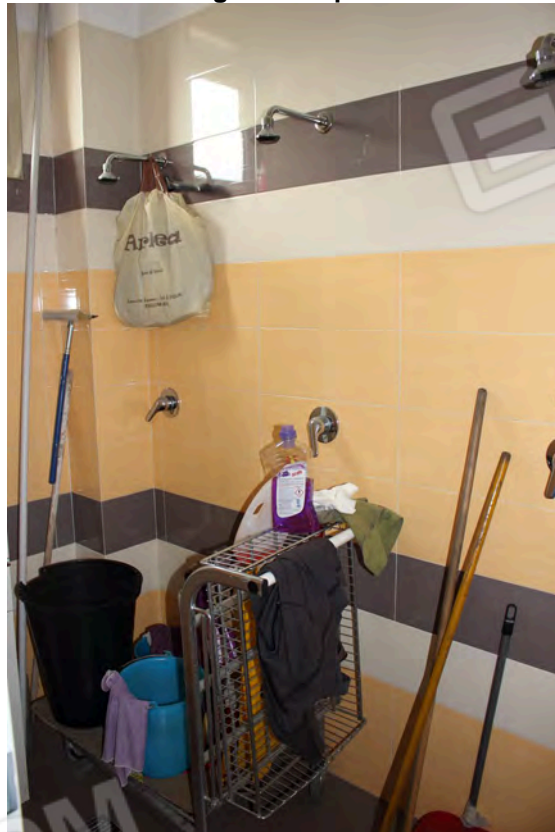
Foto 14 (Vista dei servizi igienici al piano terra - docce)
