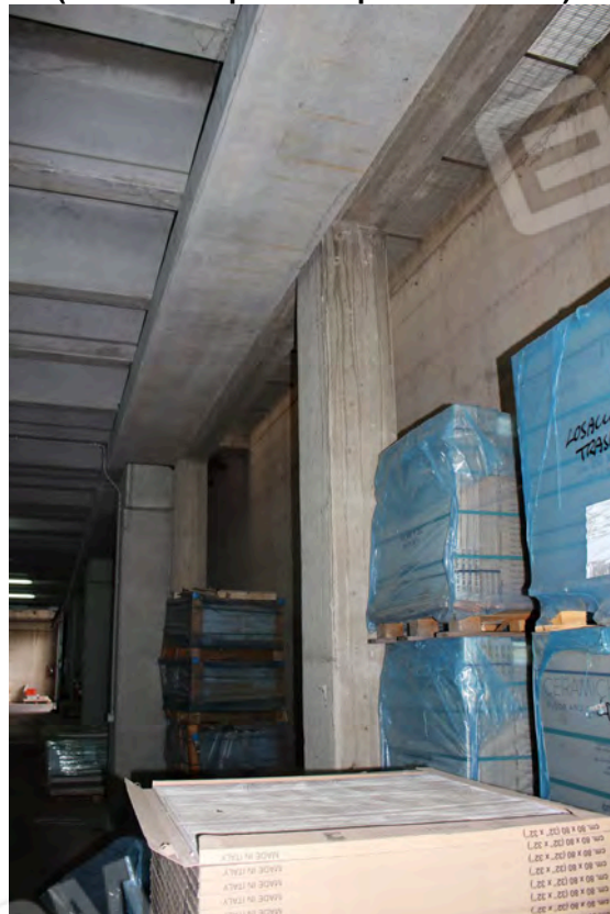
Foto 40 (Vista del deposito al piano interrato)
