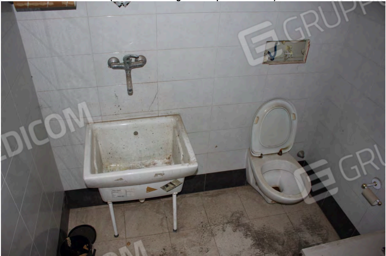
Foto 46 (Vista del locale igienico al piano interrato)
