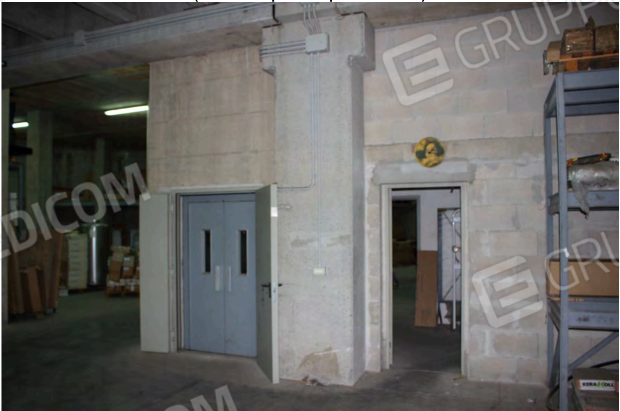
Foto 42 (Vista del deposito al piano interrato)
