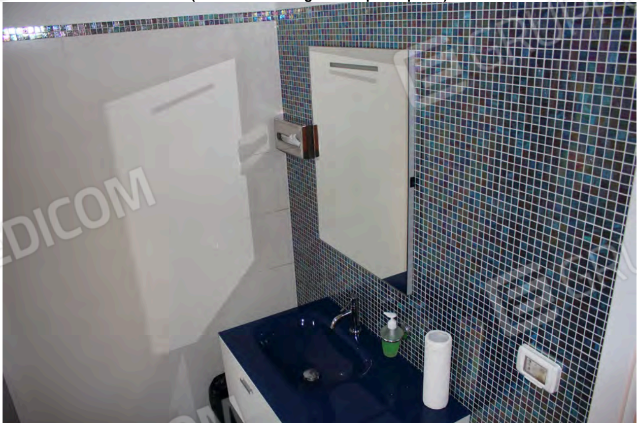
Foto 32 (Vista dei servizi igienici al primo piano)
