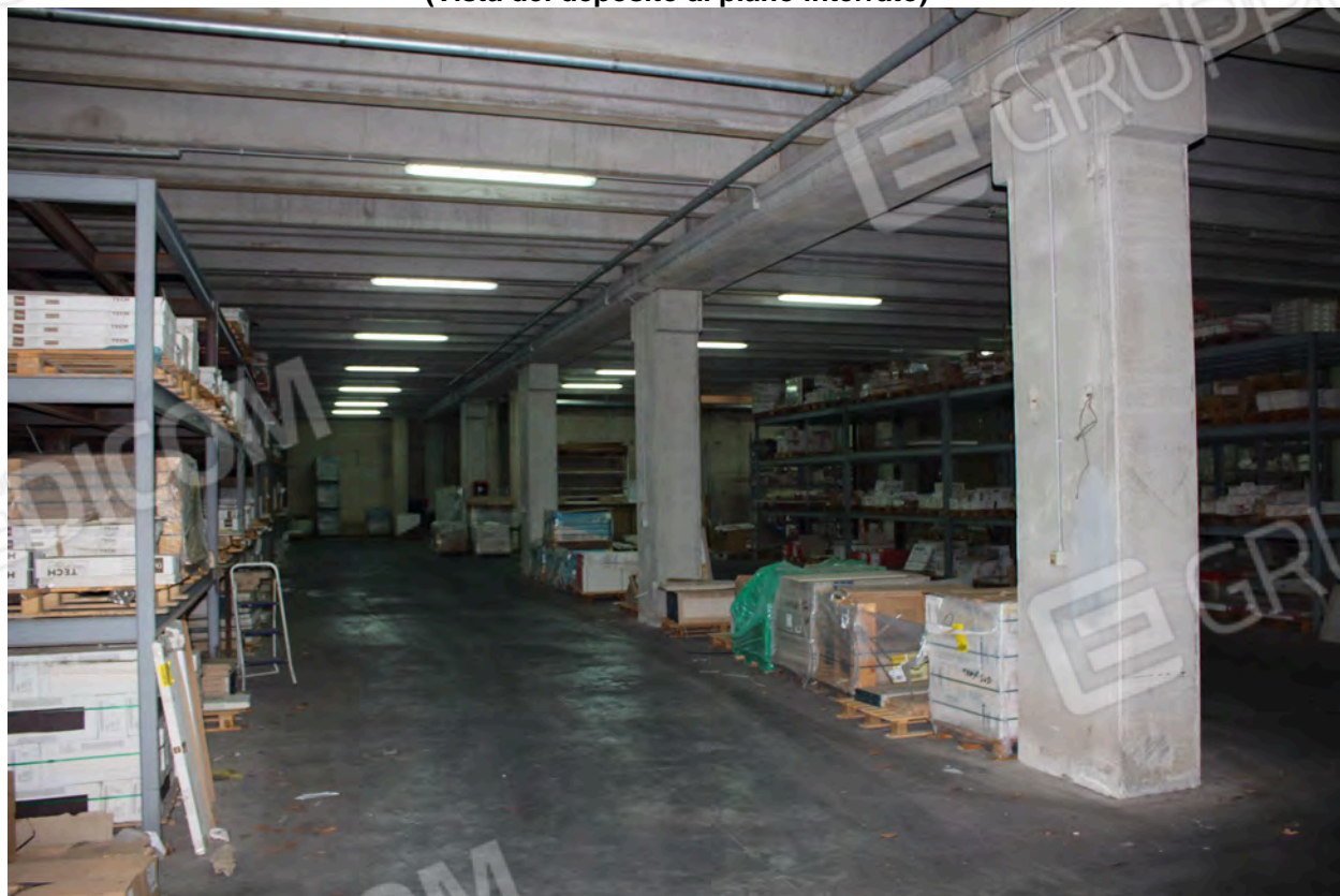
Foto 38 (Vista del deposito al piano interrato)
