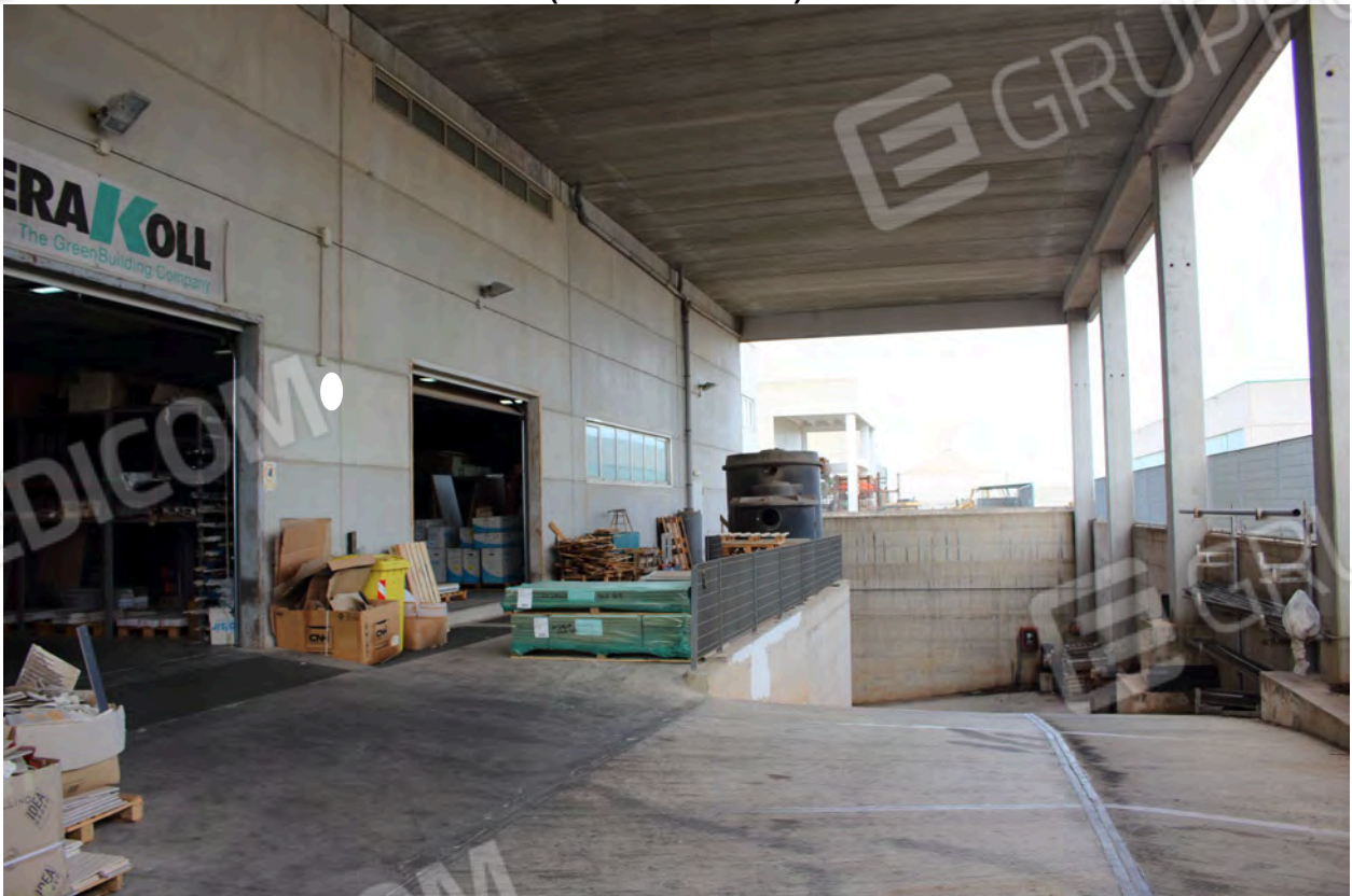
Foto 6 (Vista della tettoia)
