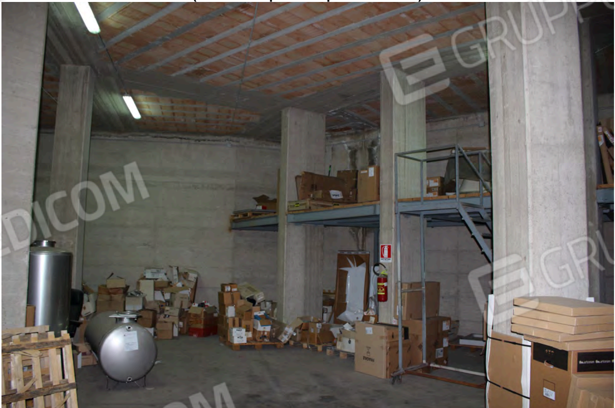
Foto 44 (Vista del deposito al piano interrato)
