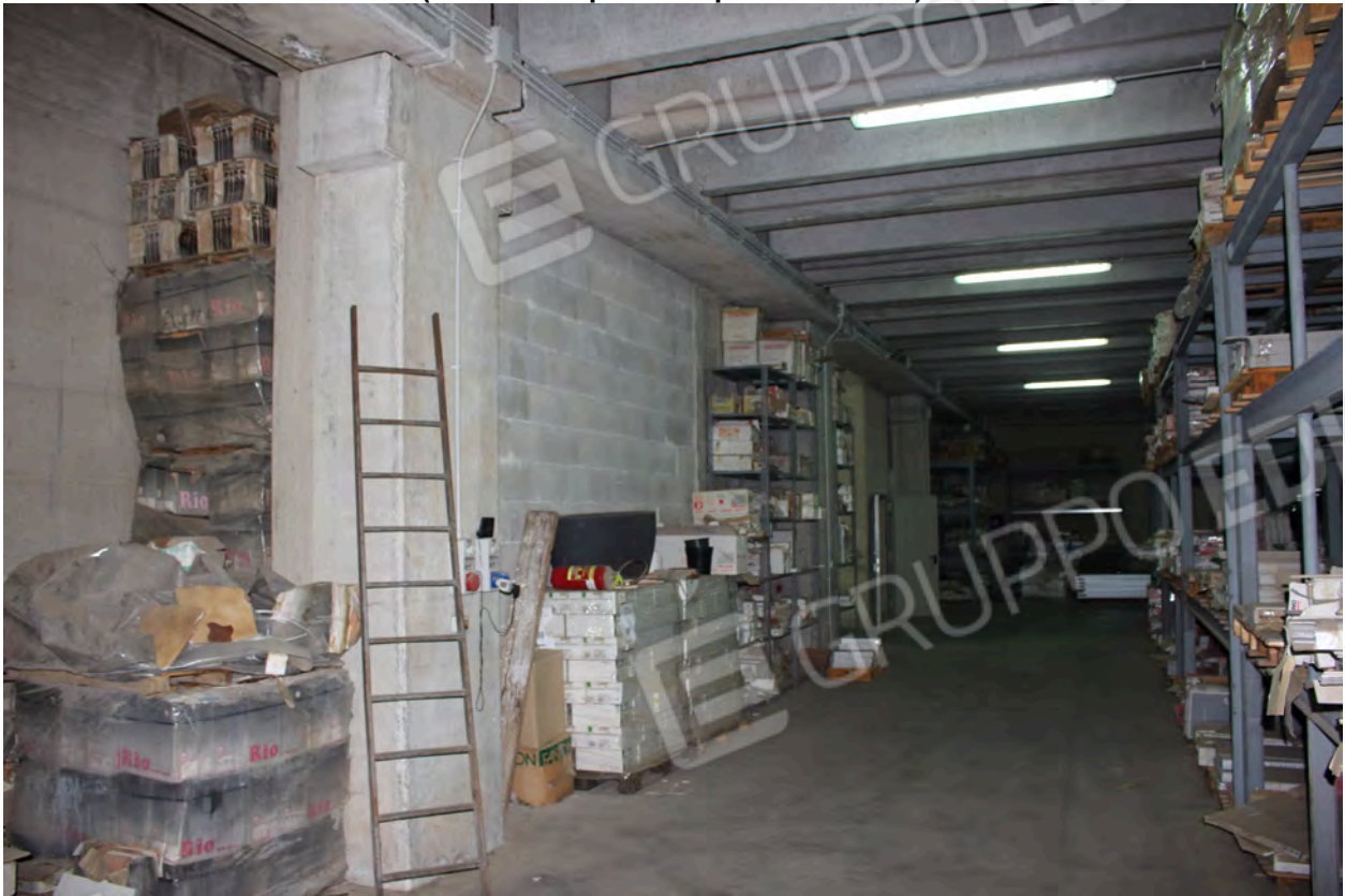
Foto 41 (Vista del deposito al piano interrato)
