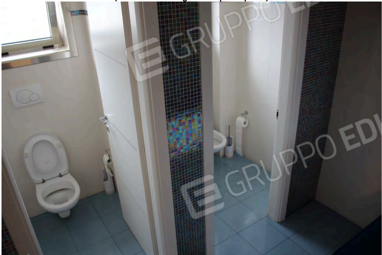
Foto 31 (Vista dei servizi igienici al primo piano)
