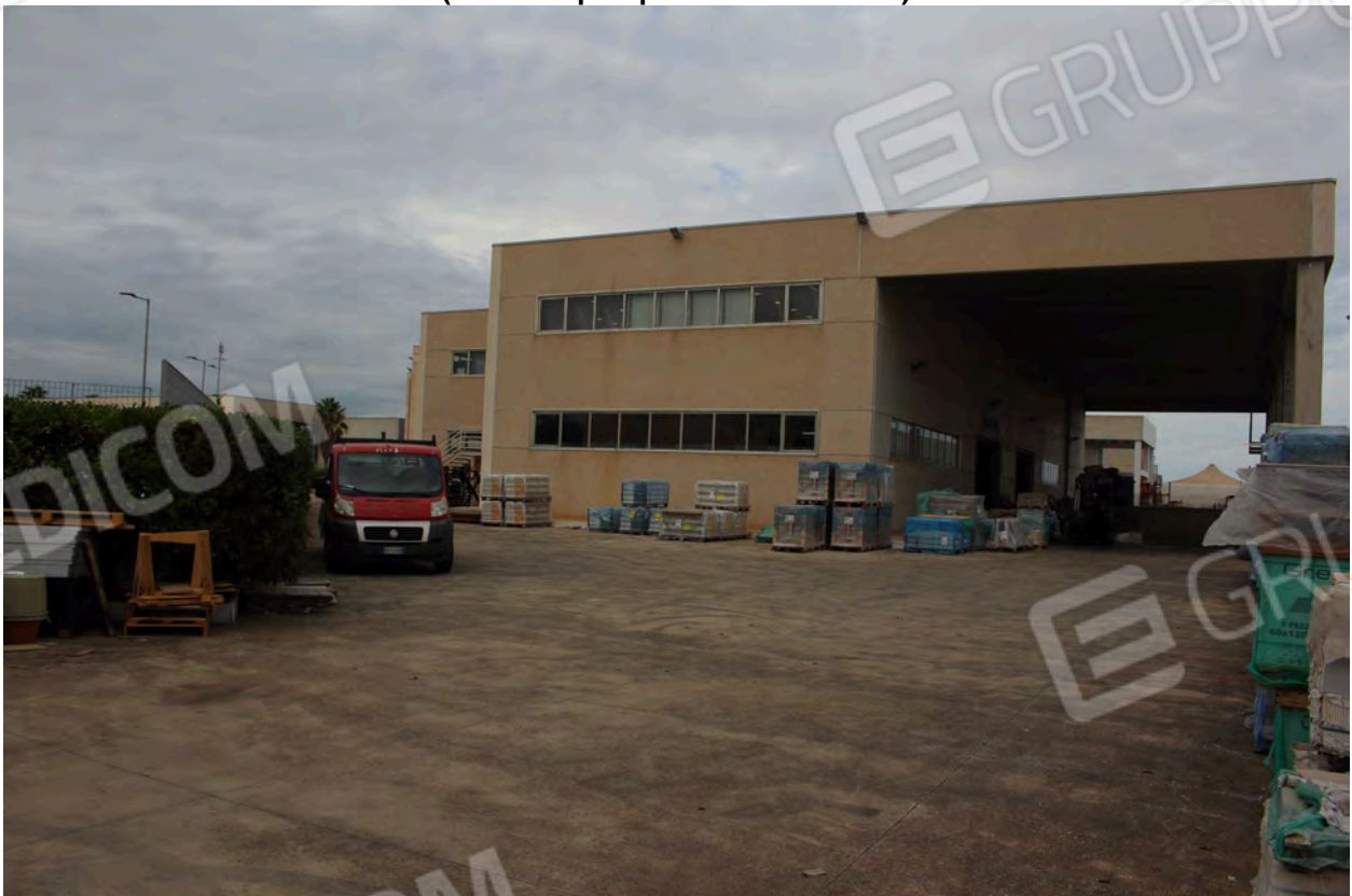
Foto 4 (Vista del prospetto e della tettoia)
