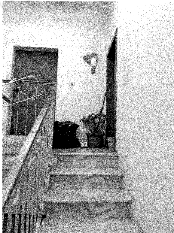
Foto 4 - Vista vano scala condominiale
