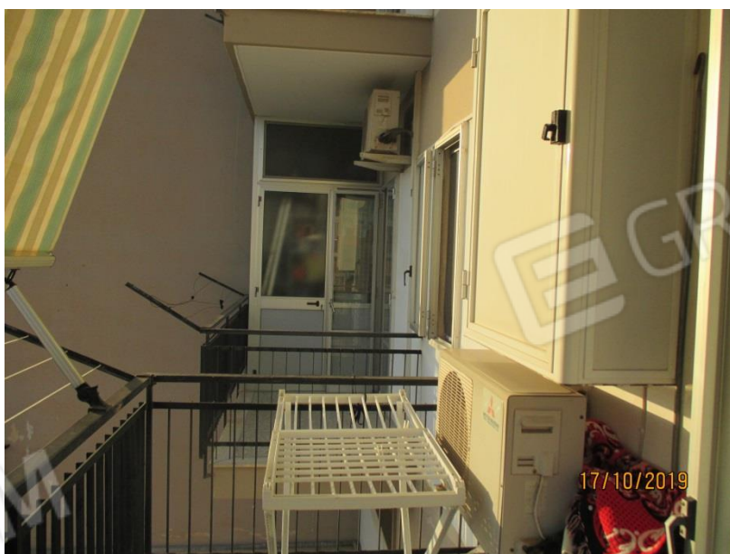
Foto n. 14 – Balconi lato sud
