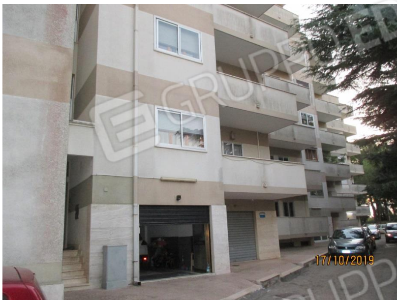
Foto n. 1 - Prospetto via Casamassima
