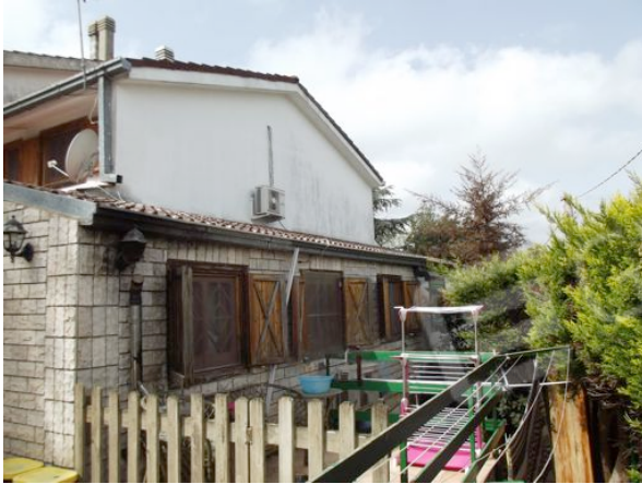
FOTO 7 – Esterno Lato Sud
