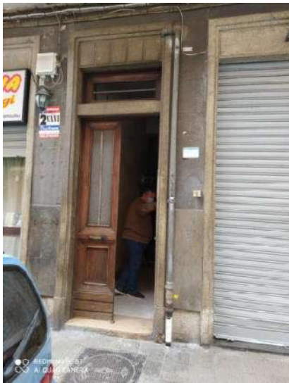
Portone d'accesso al fabbricato
