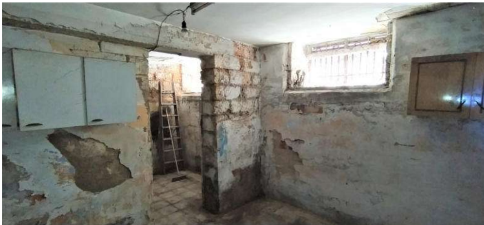
Vari ambienti del locale al piano seminterrato con vista delle finestre
