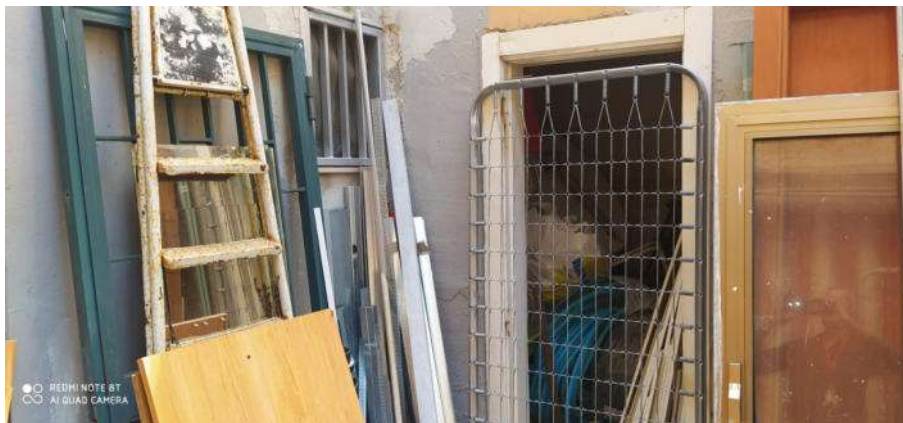
Vano bagno esterno
