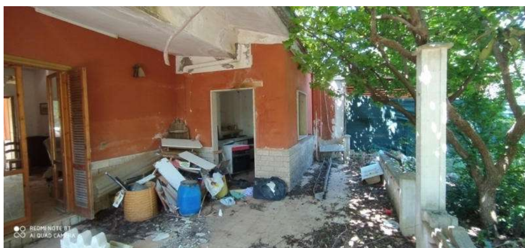
Patio retrostante con il vano della cucina esterno
