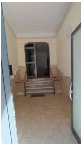
Accesso al locale
