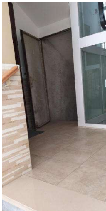
Accesso al locale
