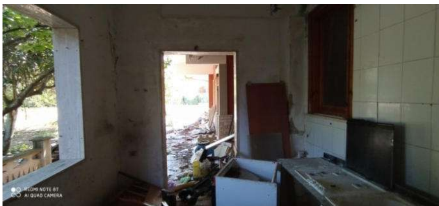
Locale cucina esterna nel patio retrostante
