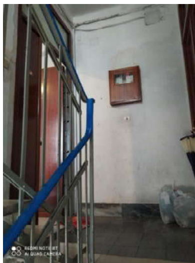
Rampa scala condominiale
