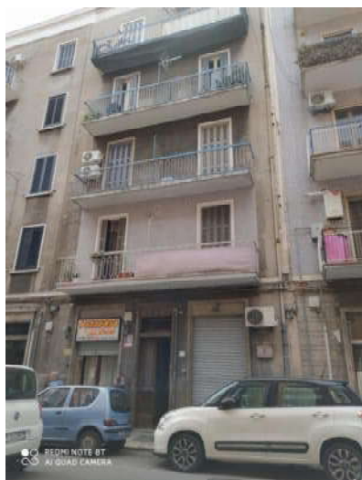
Vista del fabbricato alla via Dante n. 461
