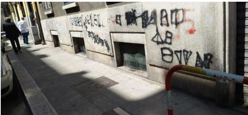
Finestre del locale seminterrato sulla via Indipendenza
