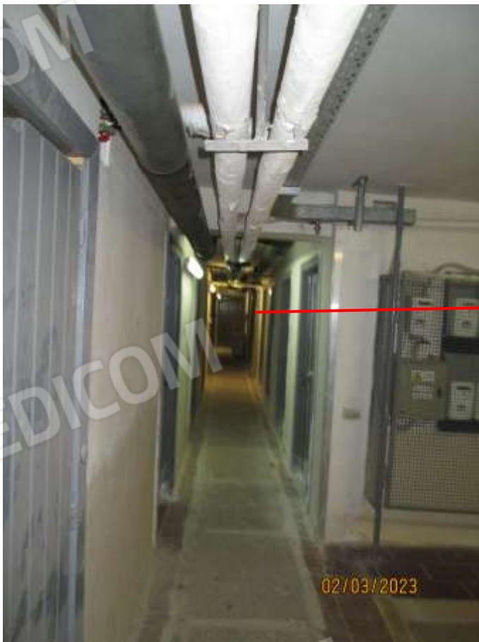
Foto n. 32: Corridoio condominiale al piano seminterrato
