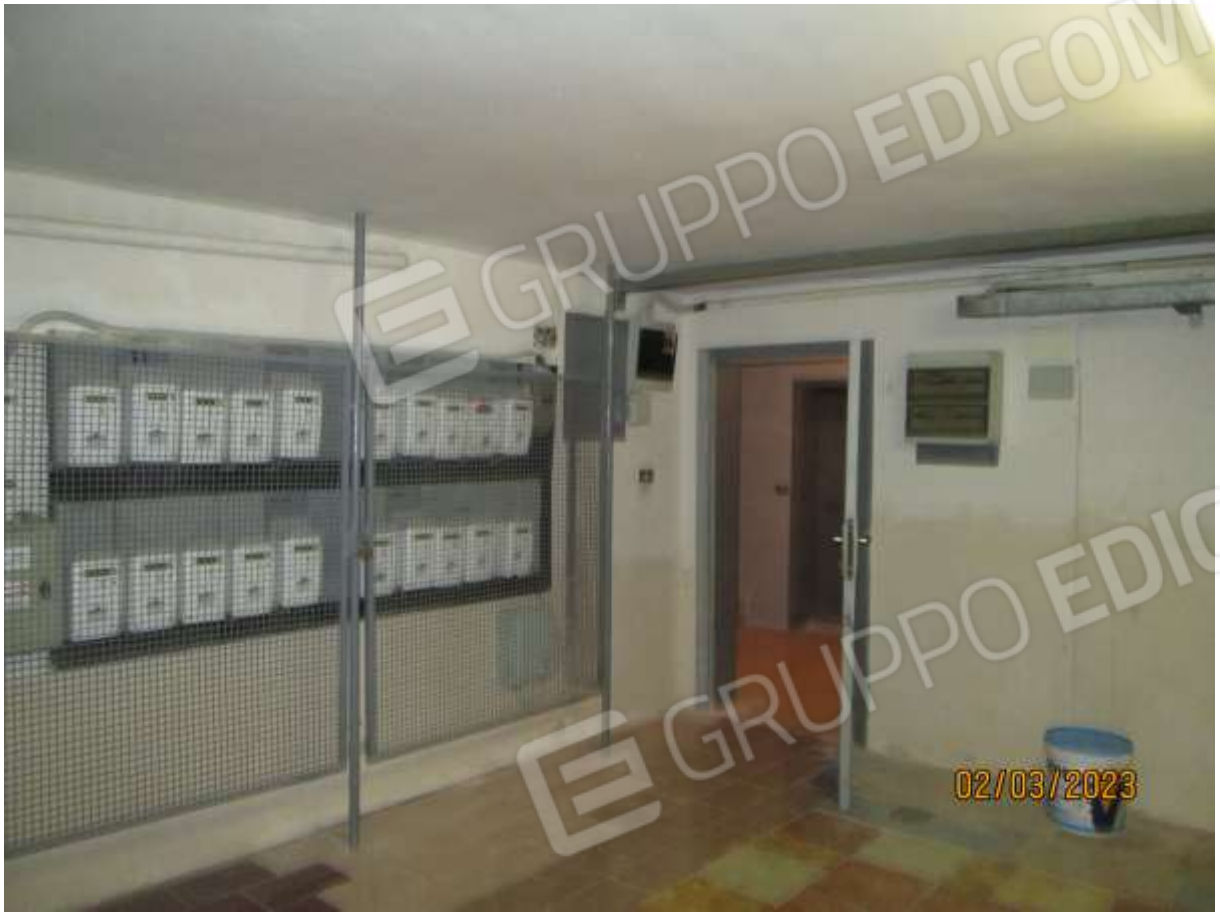
Foto n. 31: Disimpegno condominiale al piano seminterrato
