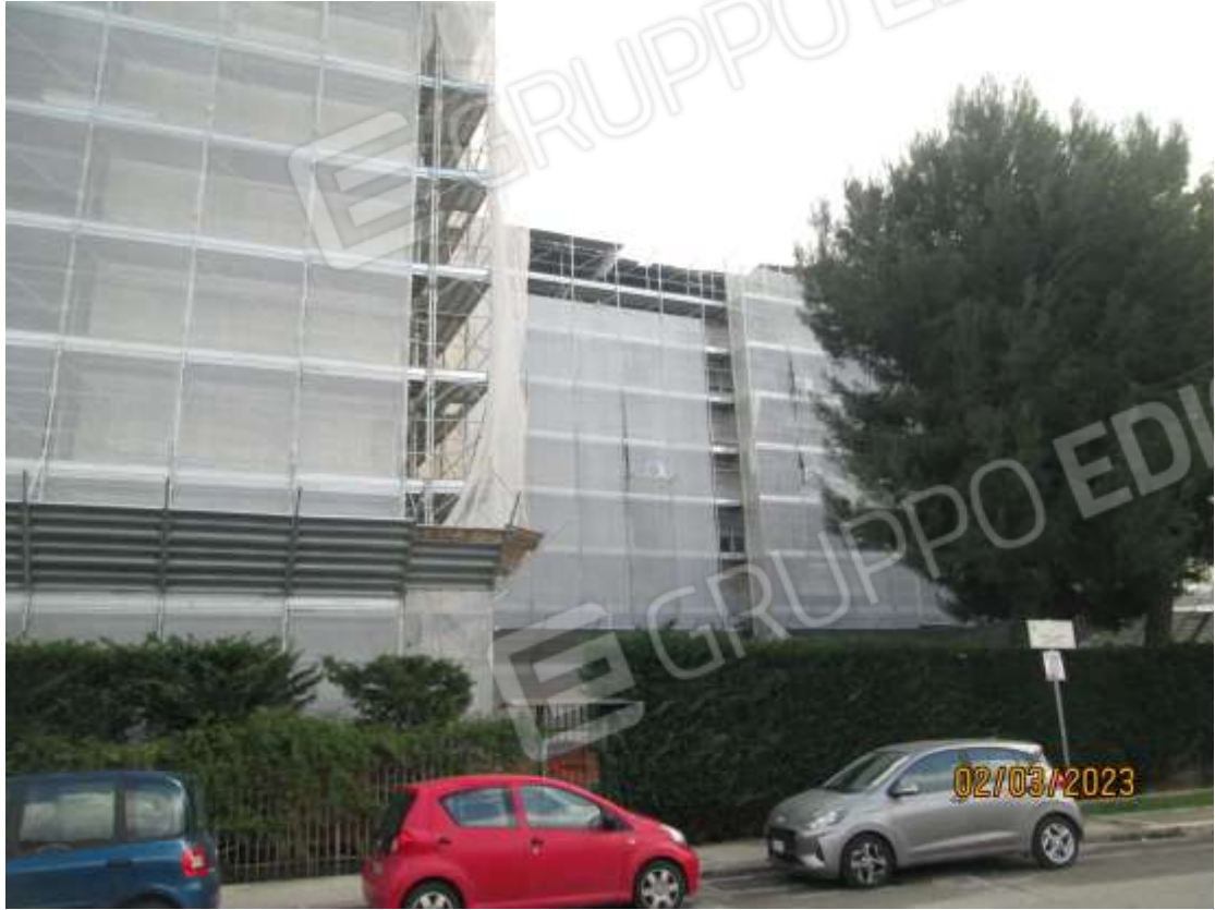
Foto n. 01: Fronte prospettico principale del fabbricato, al civico 1 G su Via Carlo Massa
