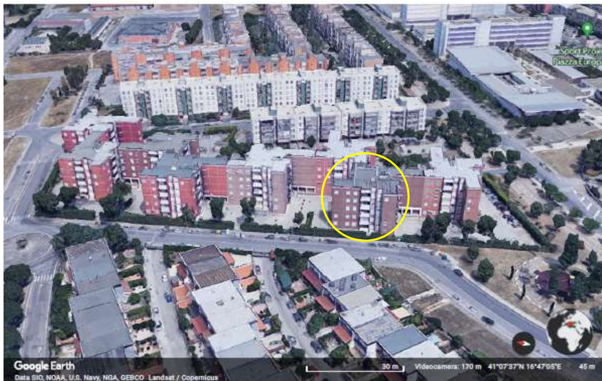
Vista satellitare, antecedente al 02/03/2023, tratta da Google Earth del complesso immobiliare "Condominio Adriatico" in Bari - San Paolo – alla Via Carlo Massa n. 1 con evidenziazione della scala G
