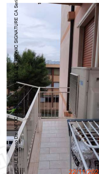
Foto 24 - Balcone su via E.Saracino
