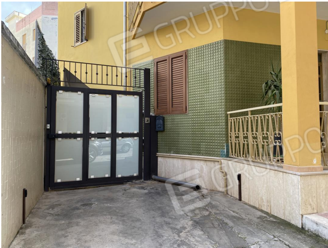
Foto 3: esterno Fabbricato– vista prospettica su Via G. De Napoli – dettaglio Cancelli Piano Terra
