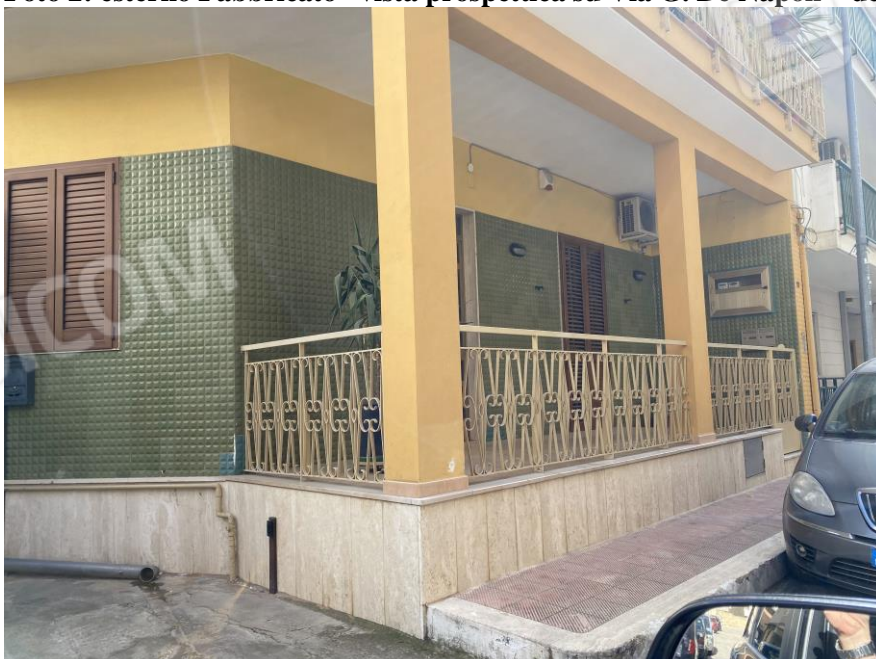
Foto 2: esterno Fabbricato– vista prospettica su Via G. De Napoli – dettaglio Piano Terra
