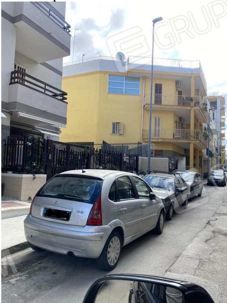
Foto 1: esterno Fabbricato– vista prospettica panoramica dell'intero stabile (in giallo) su Via G. De Napoli
