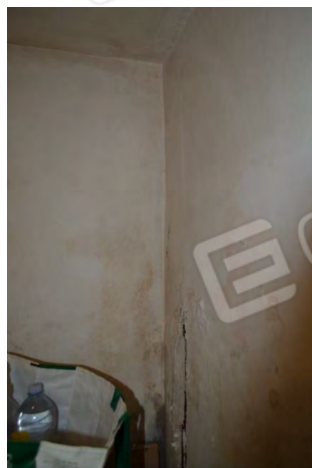
- danni da umidità nell'angolo destro verso il portone
