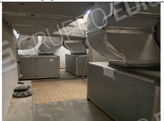
Piano interrato - locali tecnologici
