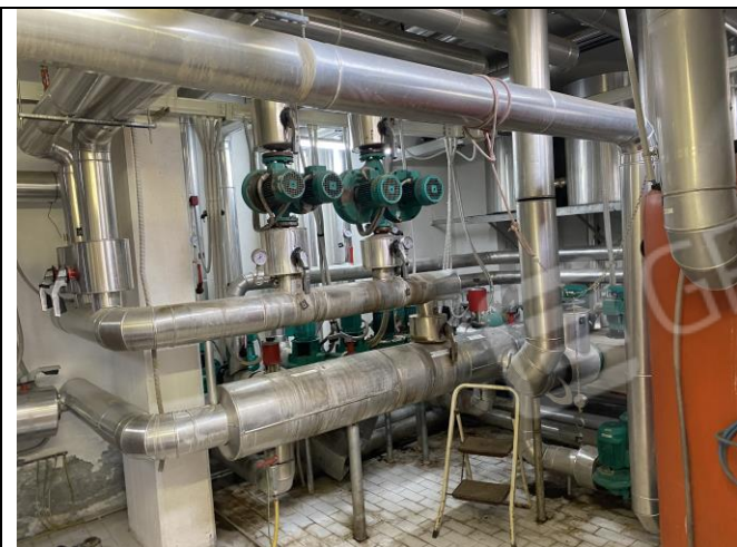
Piano interrato – locali tecnologici
