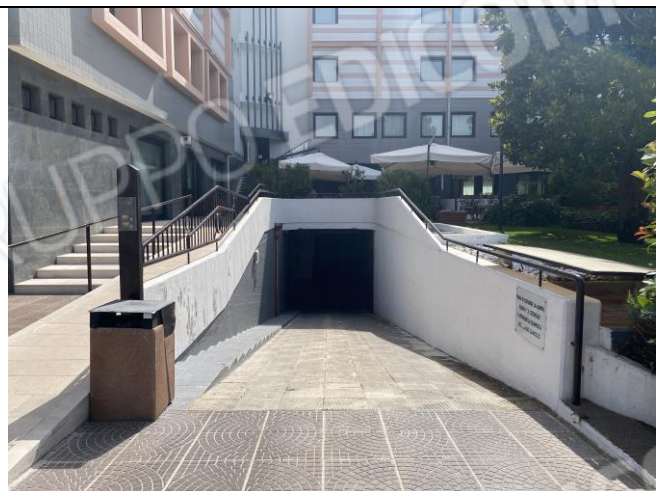
Rampa carrabile di ingresso al piano interrato – zona garage
