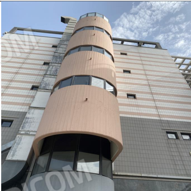
Prospetto interno lato sud
