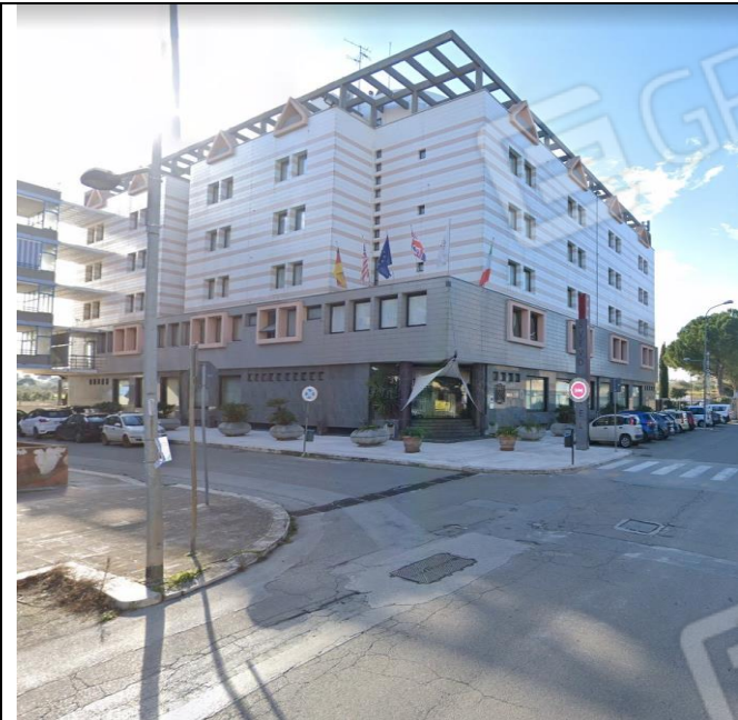
Prospetto via Cassano – ingresso principale
