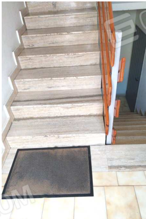
FOTO NN. 9-10: ANDRONE VANO SCALA D'ACCESSO ALLO STABILE CONDOMINIALE CUI APPARTIENE L'IMMOBILE IN STIMA. SULLA DESTRA, RAMPA SCALE D'ACCESSO ALLE CANTINOLE ED AL BOX AUTO.
