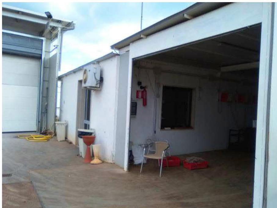
La struttura portante in adiacenza al locale mensa è metallica con chiusure verticali ed orizzontali realizzate con pannelli coibentati.
