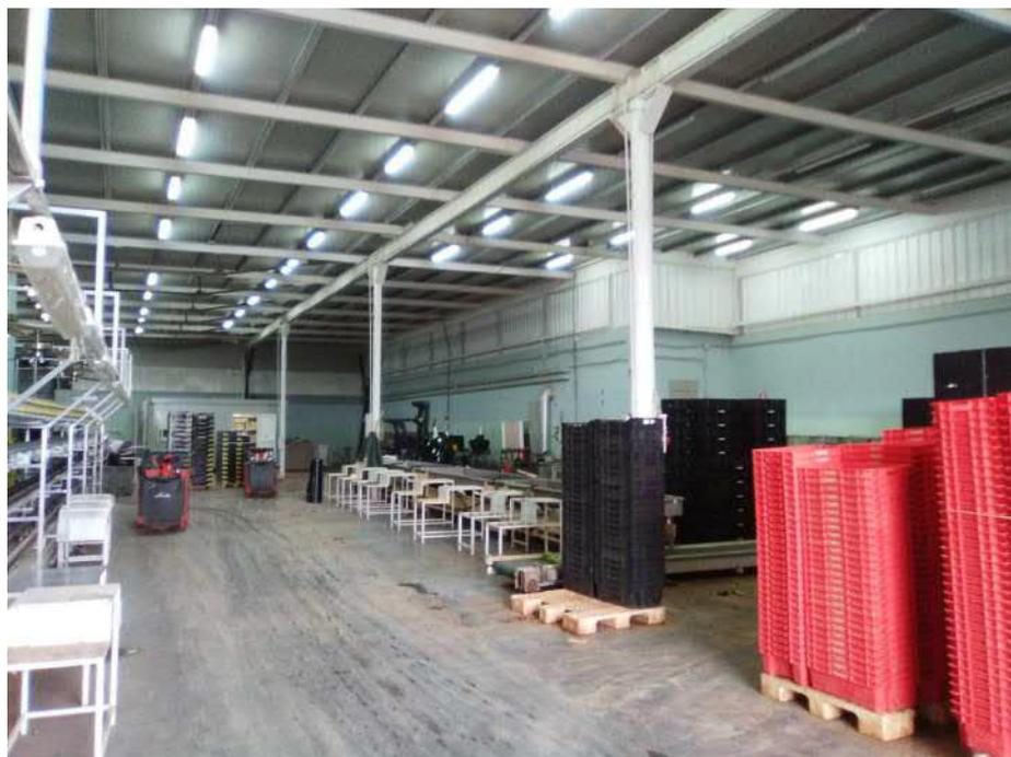
L'area lavorazione 1 è stata realizzata con elementi portanti metallici incastrati alla base con plinti isolati realizzati in calcestruzzo non armato e strutture orizzontali ancora metalliche di supporto dei tegoli prefabbricati leggeri sovrastanti. Le pareti sono in blocchetti
