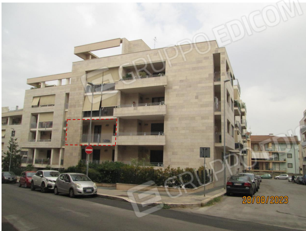
Foto n. 03: Fronte prospettico del fabbricato su Via Manfredonia angolo Via San Giovanni Rotondo con delimitazione degli esterni del lotto 2
