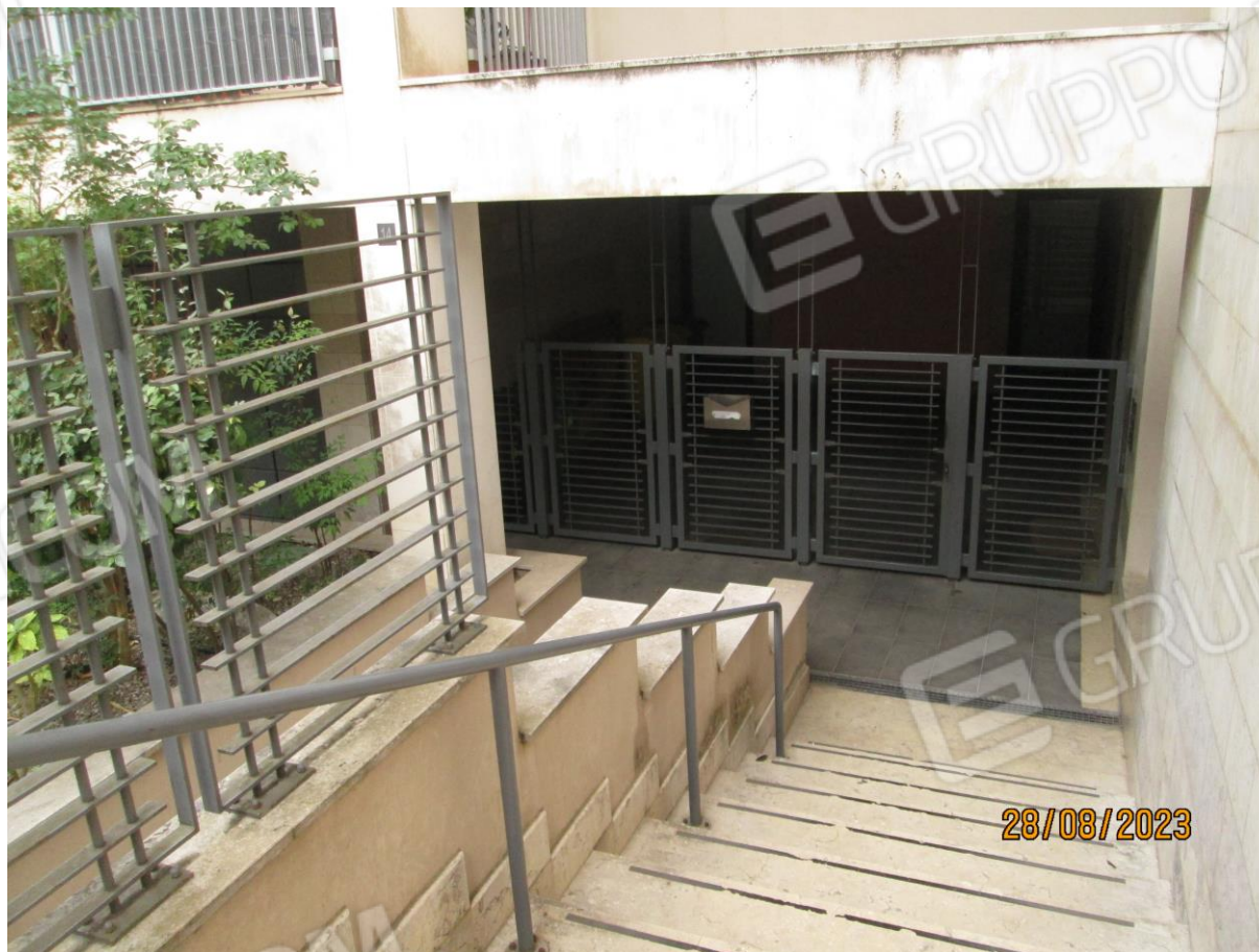
Foto n. 04: Accesso al fabbricato condominiale al civico 14 di Via Manfredonia
