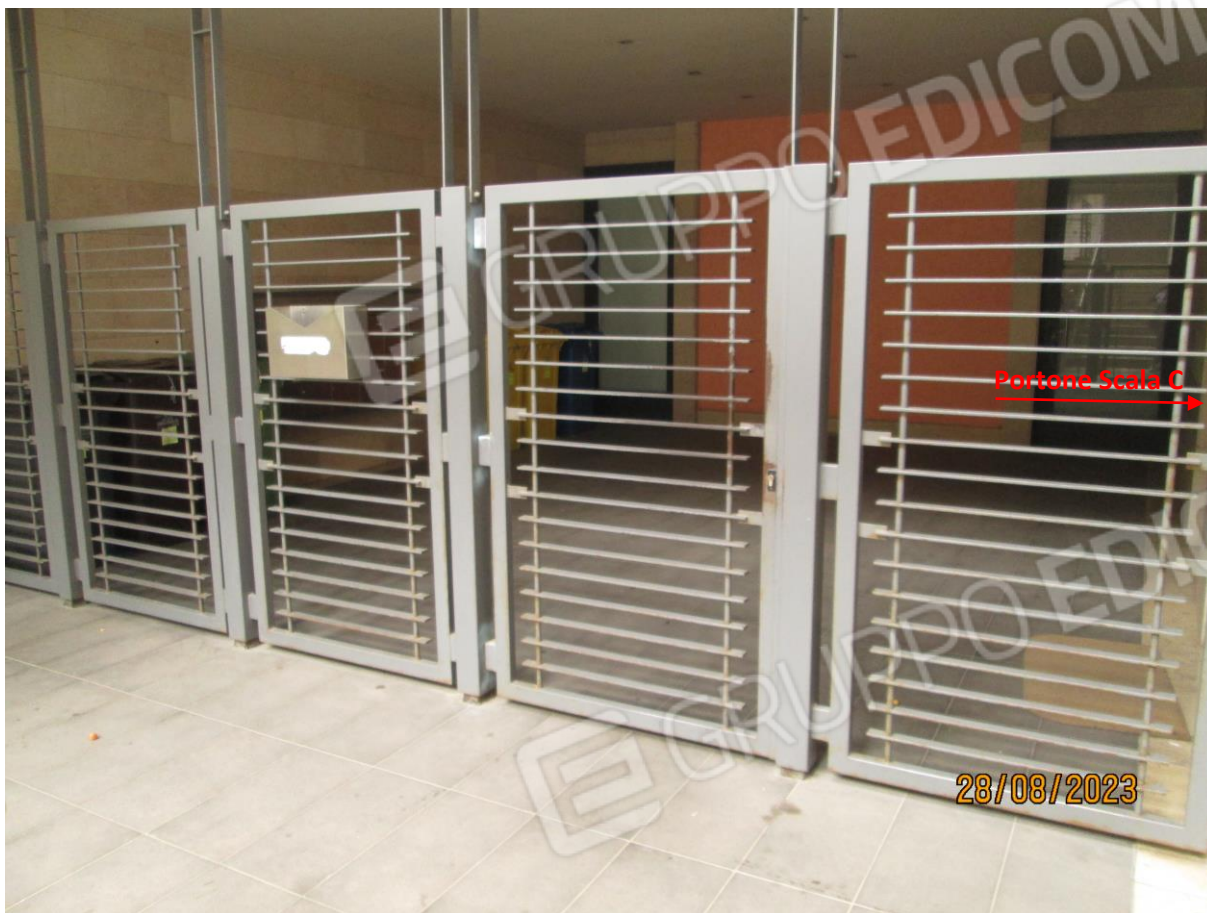
Foto n. 05: Atrio esterno condominiale di accesso al portone della scala C
