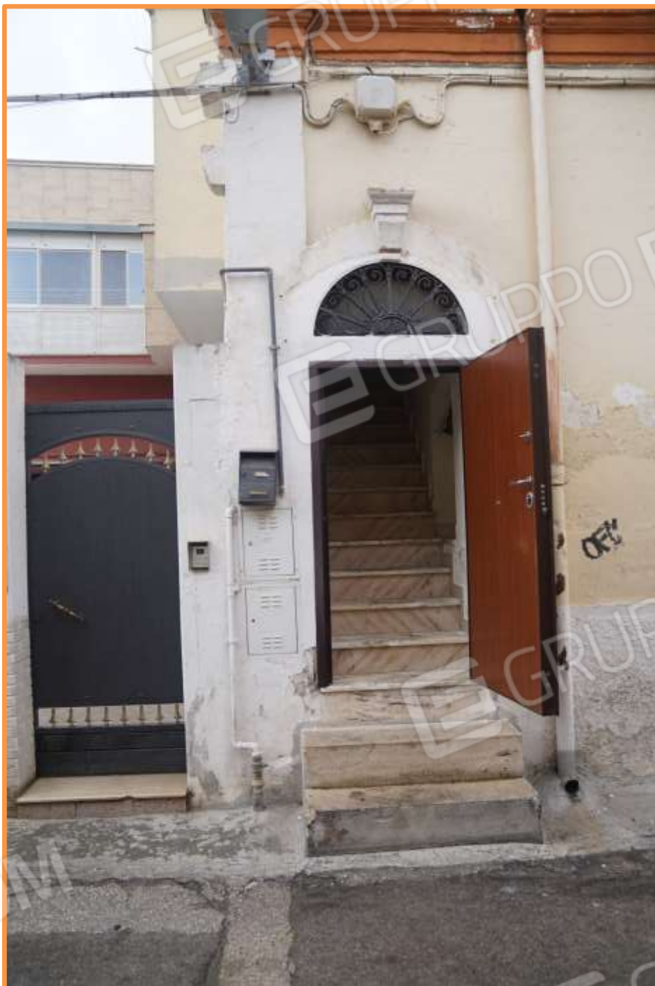
FOTO n° 3. Via Dei Mile civico 27. Particolari dell'ingresso all'abitazione. Vista verso la direzione ovest.
