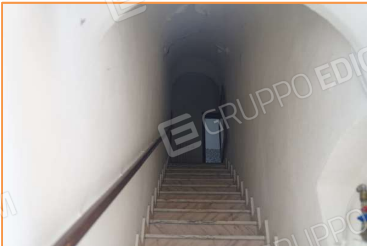
FOTO n° 4. Scala di accesso all'abitazione. Vista verso la direzione ovest.
