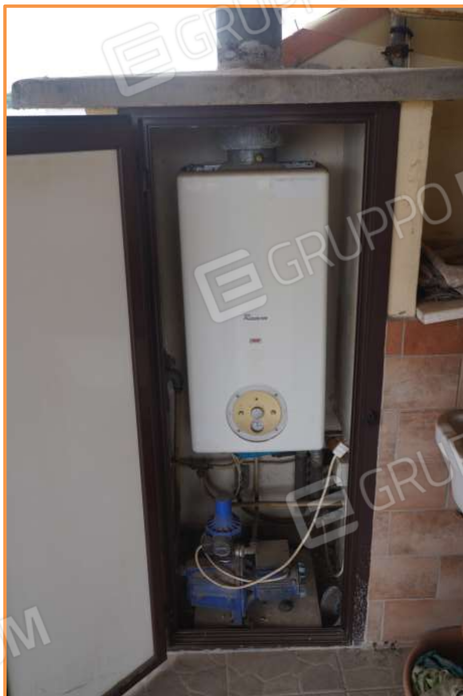
FOTO n° 27. Particolare dell'armadio-volume tecnico. Vista verso la direzione sud.
