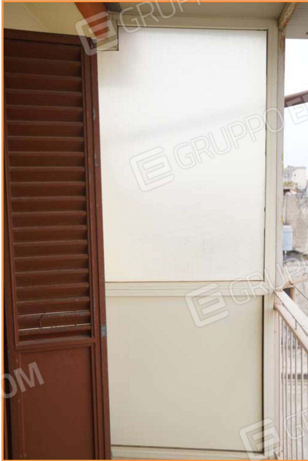
FOTO n° 20. Balcone accessibile dal ballatoio-disimpegno. Vista verso la direzione est.
