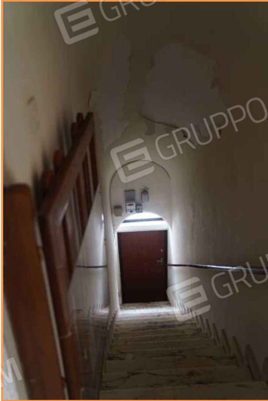
FOTO n° 6. Vista del vano scala verso il portoncino di ingresso ( direzione est ).
