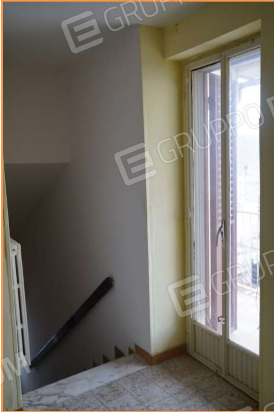
FOTO n° 19. Ballatoio di arrivo al secondo piano e che funge da disimpegno. Vista verso la direzione sud-est. Il finestrone immette su di un balcone che prospetta all'interno dell'isolato urbano, verso la direzione sud.
