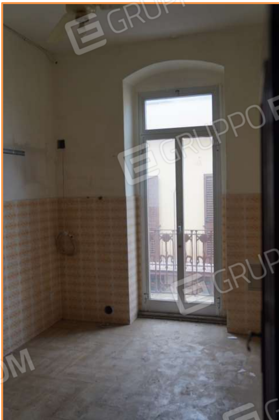
FOTO N° 11 Vano cucina. Vista verso la direzione nord.
