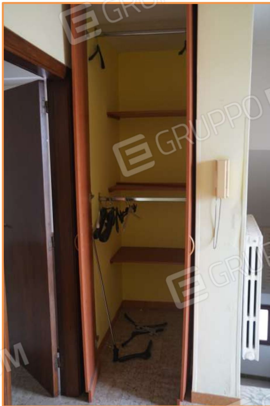
FOTO n° 22. Ballatoio di arrivo al secondo piano e che funge da disimpegno. Vista verso la direzione est. In primo piano è visibile un vano armadio a muro con ante di legno. A sinistra è visibile la porta di accesso alla camera.
