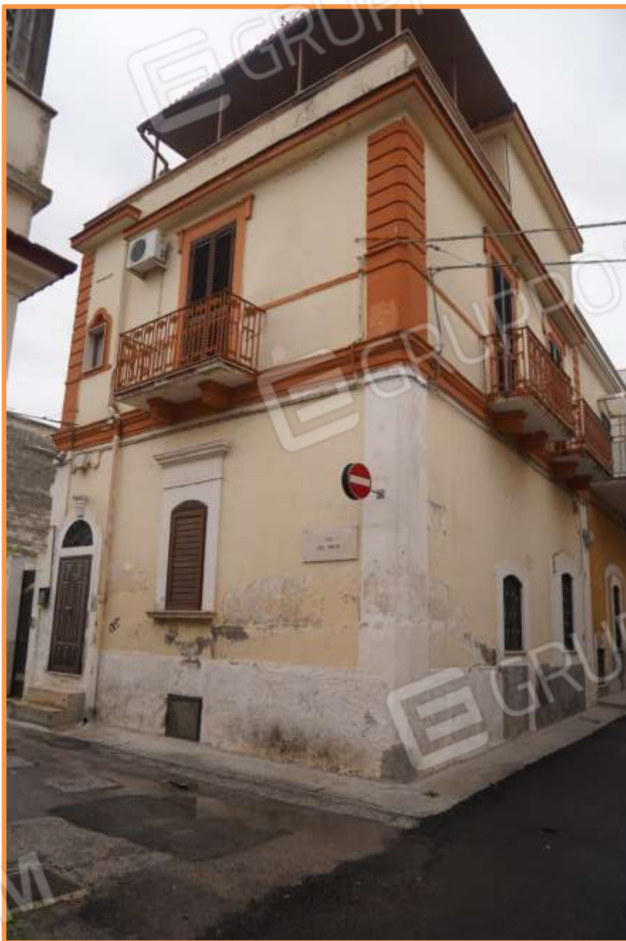
FOTO n° 1. Bari - Ceglie Del Campo. Vista verso la direzione sud-ovest dell'edificio in cui è sito il bene immobile pignorato. L'accesso è costituito dal portoncino posto a sinistra (civico 27) e l'unità staggiata conforma il primo ed il secondo piano.
