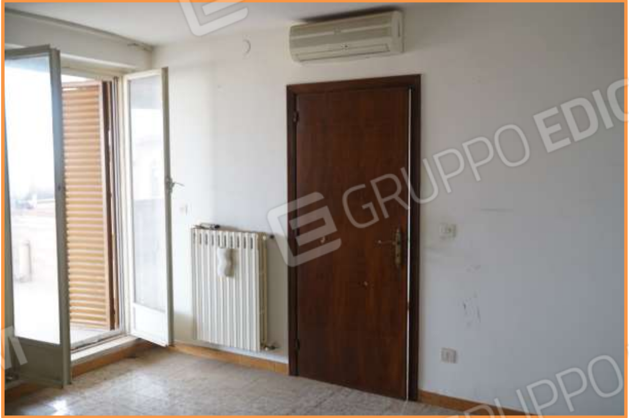
FOTO n° 23. Camera del secondo piano. Vista verso la direzione sud-est. A destra è visibile la porta di accesso al ballatoio di arrivo al secondo piano- disimpegno. A sinistra è visibile il finestrone che immette sulla terrazza a livello.
