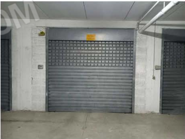
Vista interna serranda di accesso al Box
