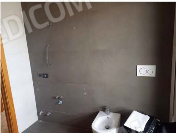
Vista interna vano bagno
