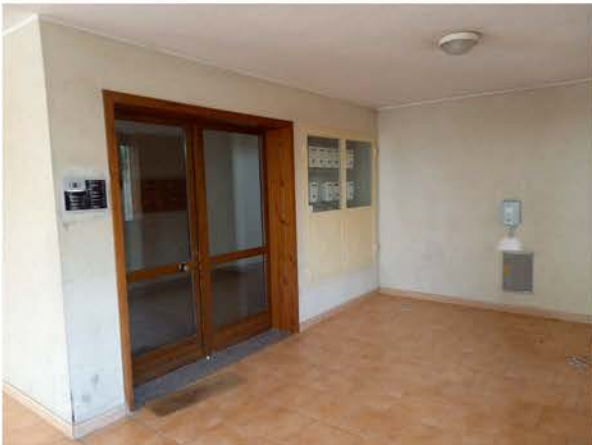
Vista esterna Portone d'Ingresso
