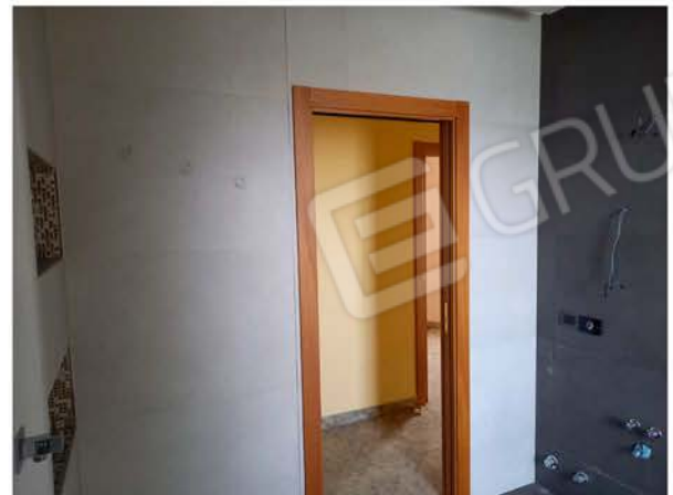
Vista interna vano bagno
