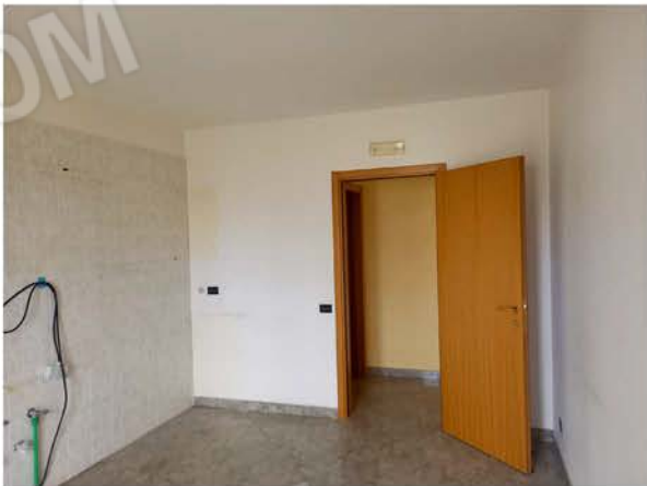
Vista interna vano cucina
