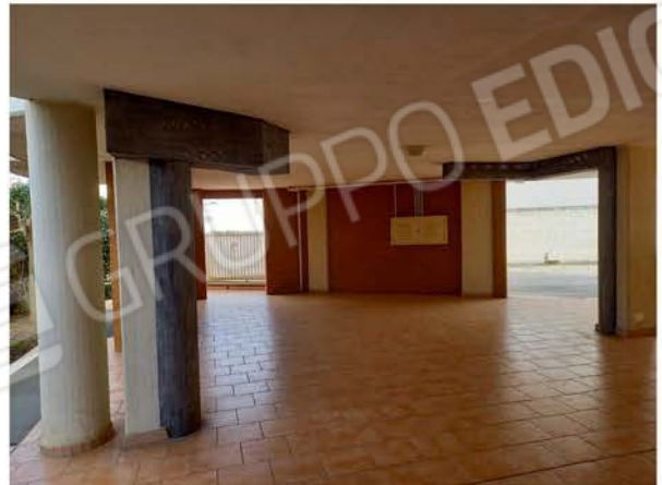
Vista esterna porticato di accesso
