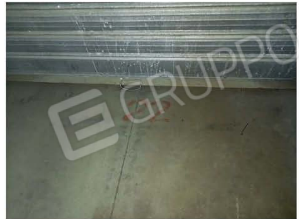
Vista interna particolare pavimento/serranda
