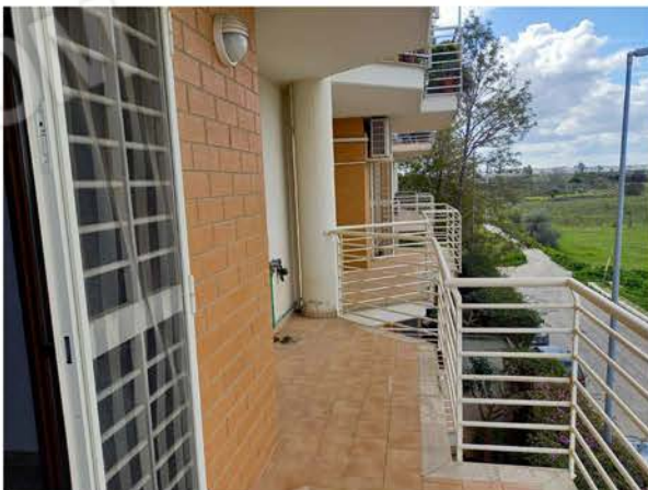
Vista esterna balcone a Sud/Ovest verso Sud
