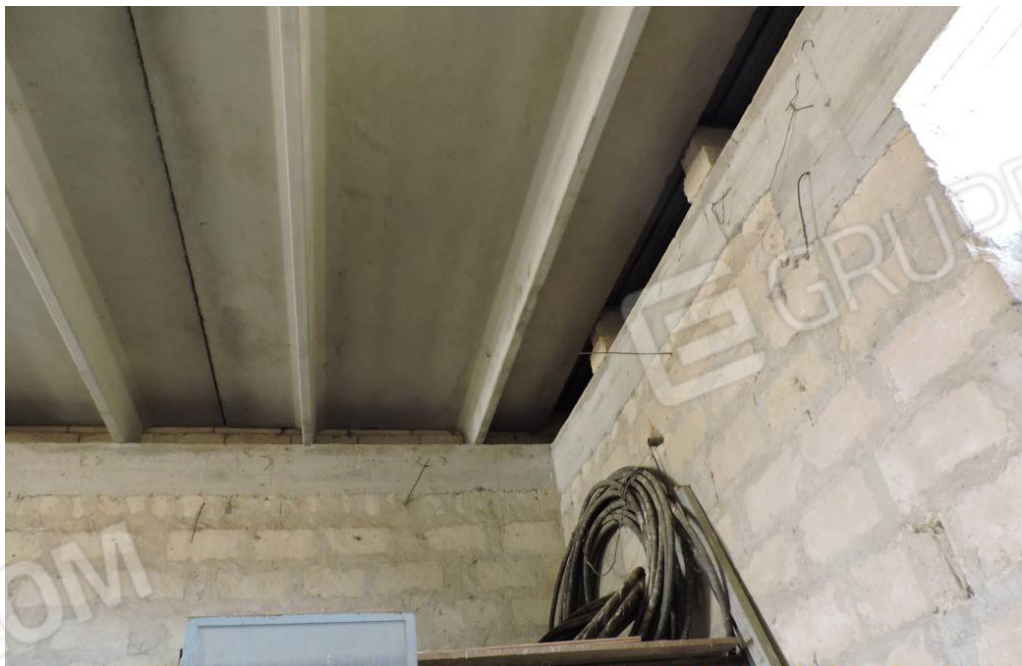
Vista dello stesso dall'interno verso l'esterno e particolare della copertura.
