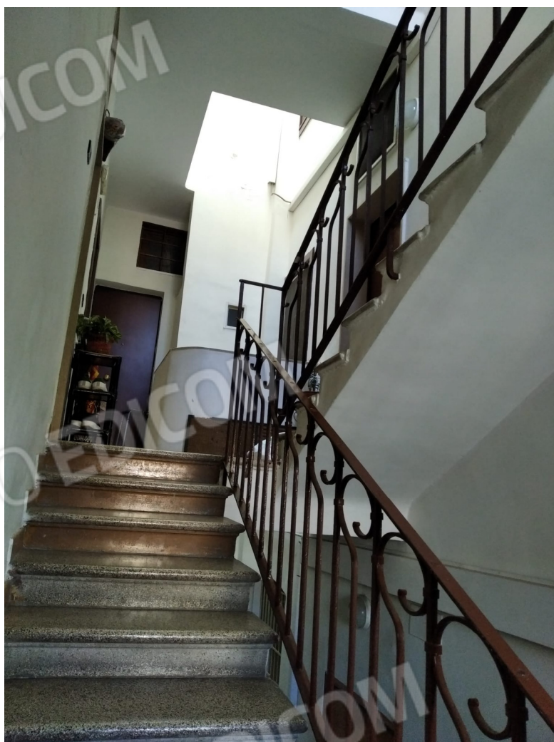
Foto n.4 Vano scale condominiali
