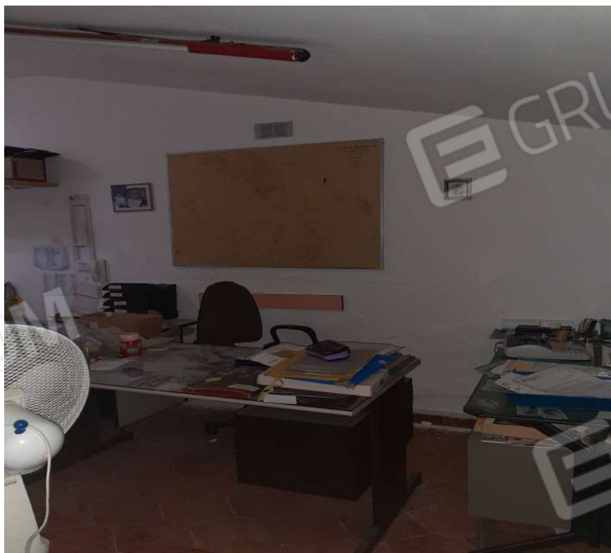
Foto n. 3 Locale sotto rampa
