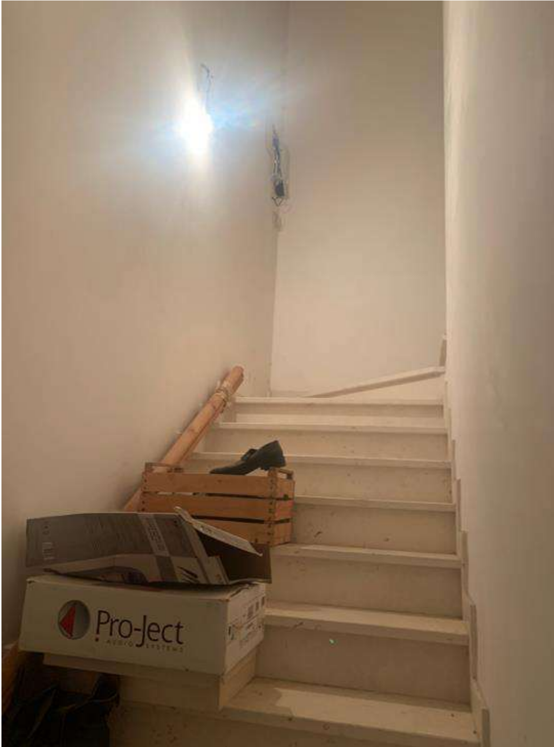
VANO SCALA INTERNO
