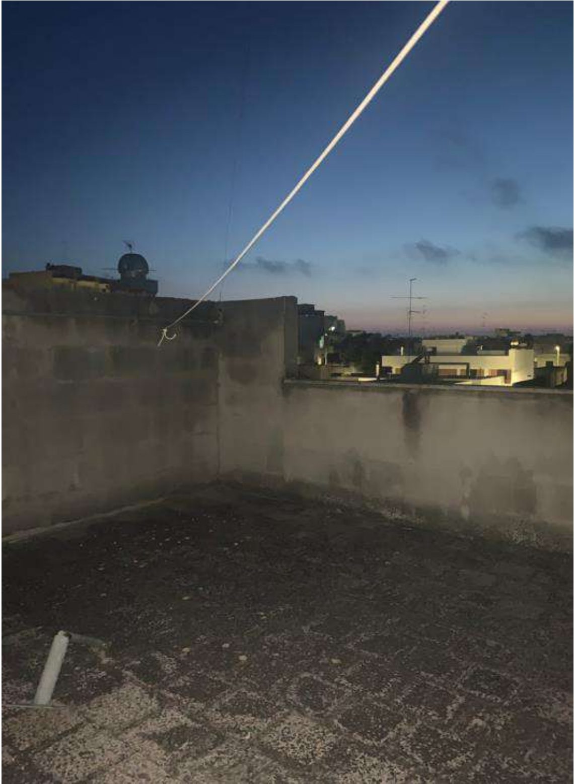
LASTRICO SOLARE PIANO SECONDO
