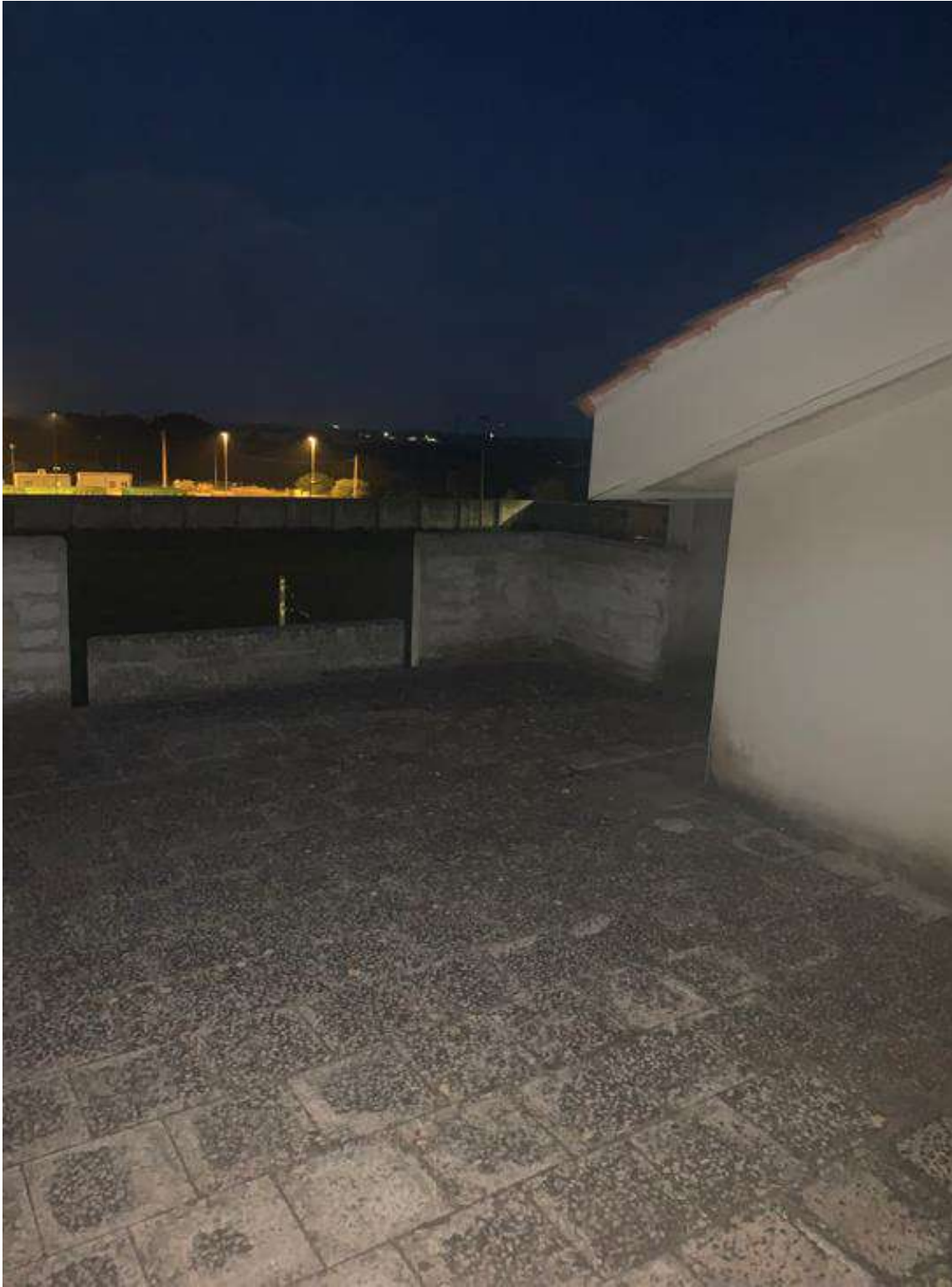
LASTRICO SOLARE PIANO SECONDO
