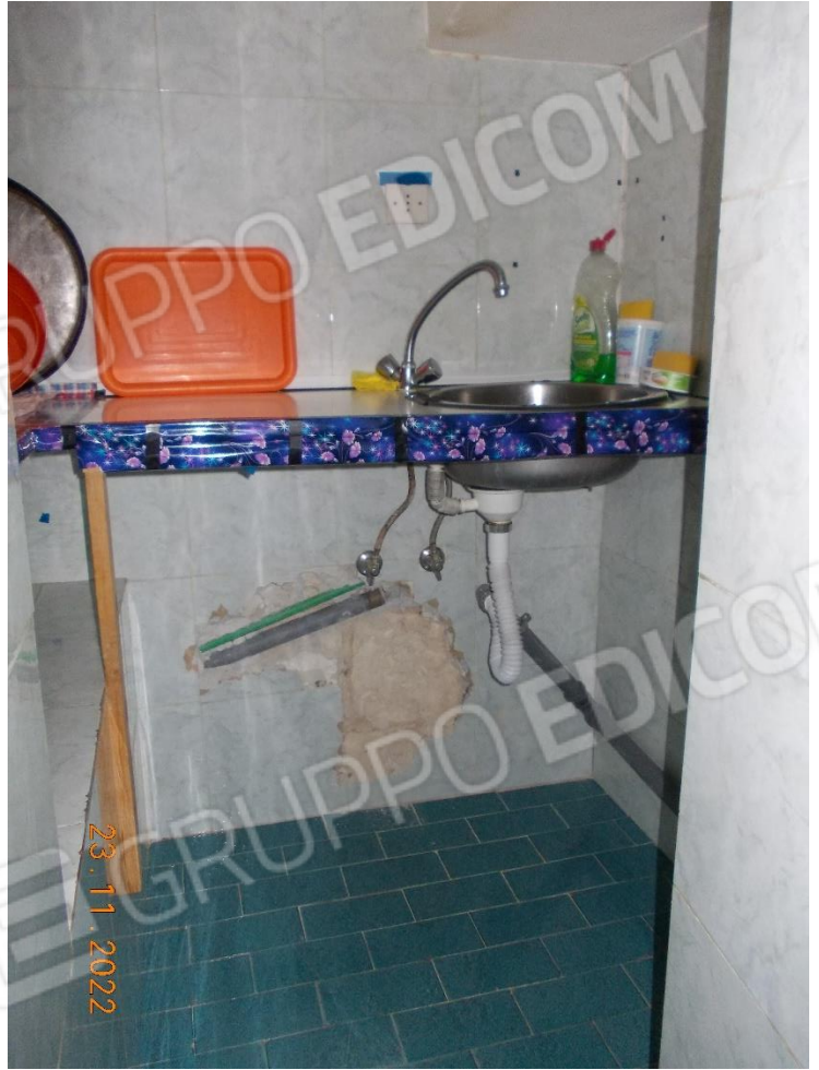
FOTO 6 – Ripostiglio-lavatoio, sull'estradosso della scala di accesso
