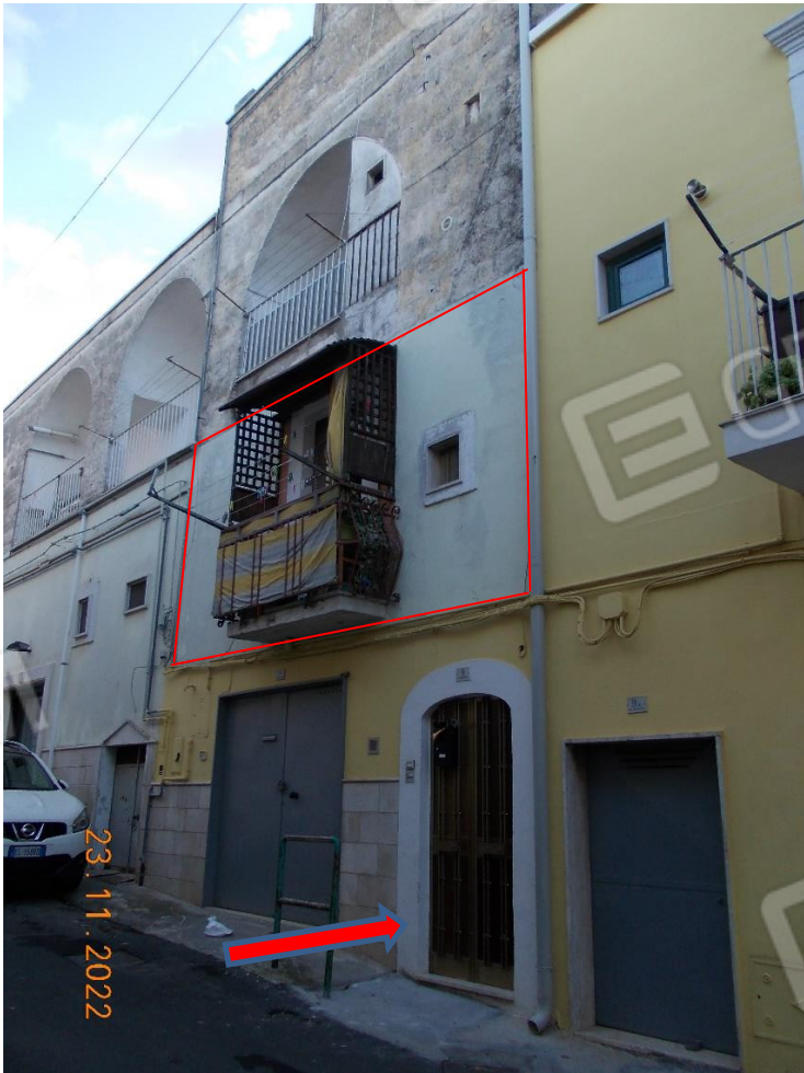
FOTO 1 – Accesso da Via Dardanelli, 9
