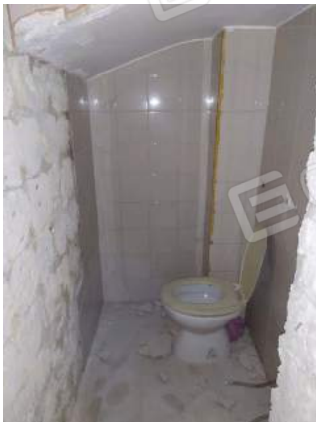
Foto 11 – nicchia per alloggiamento vaso
