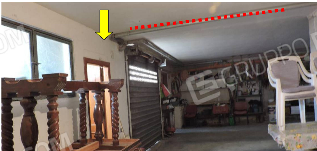
Panoramica_4 del deposito. La linea tratteggiata in rosso ricalca il confine non materializzato. La freccia gialla indica l'ingresso al locale cantina.
