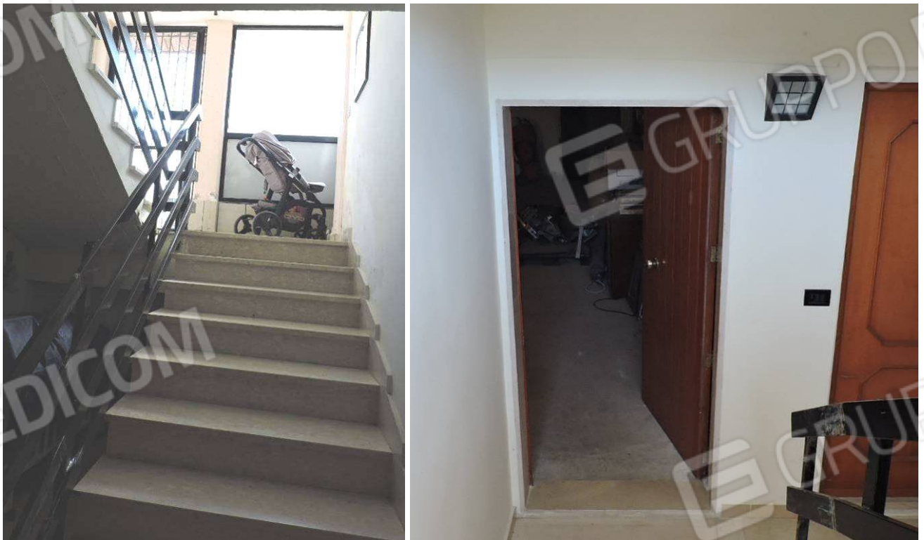
Vano scala comune, rampa di accesso al piano interrato. Ingresso al locale deposito al piano interrato
