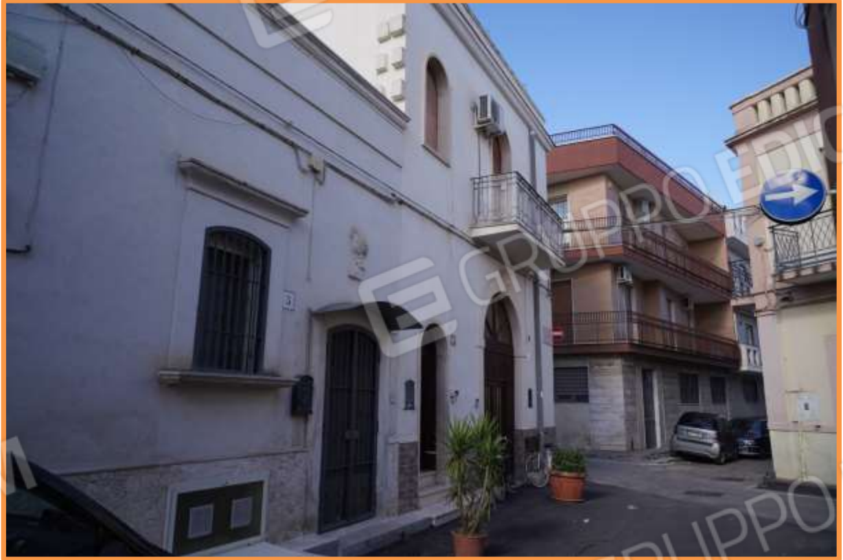
FOTO n° 3. Come foto n° 2. Vista verso la direzione nord-ovest.
