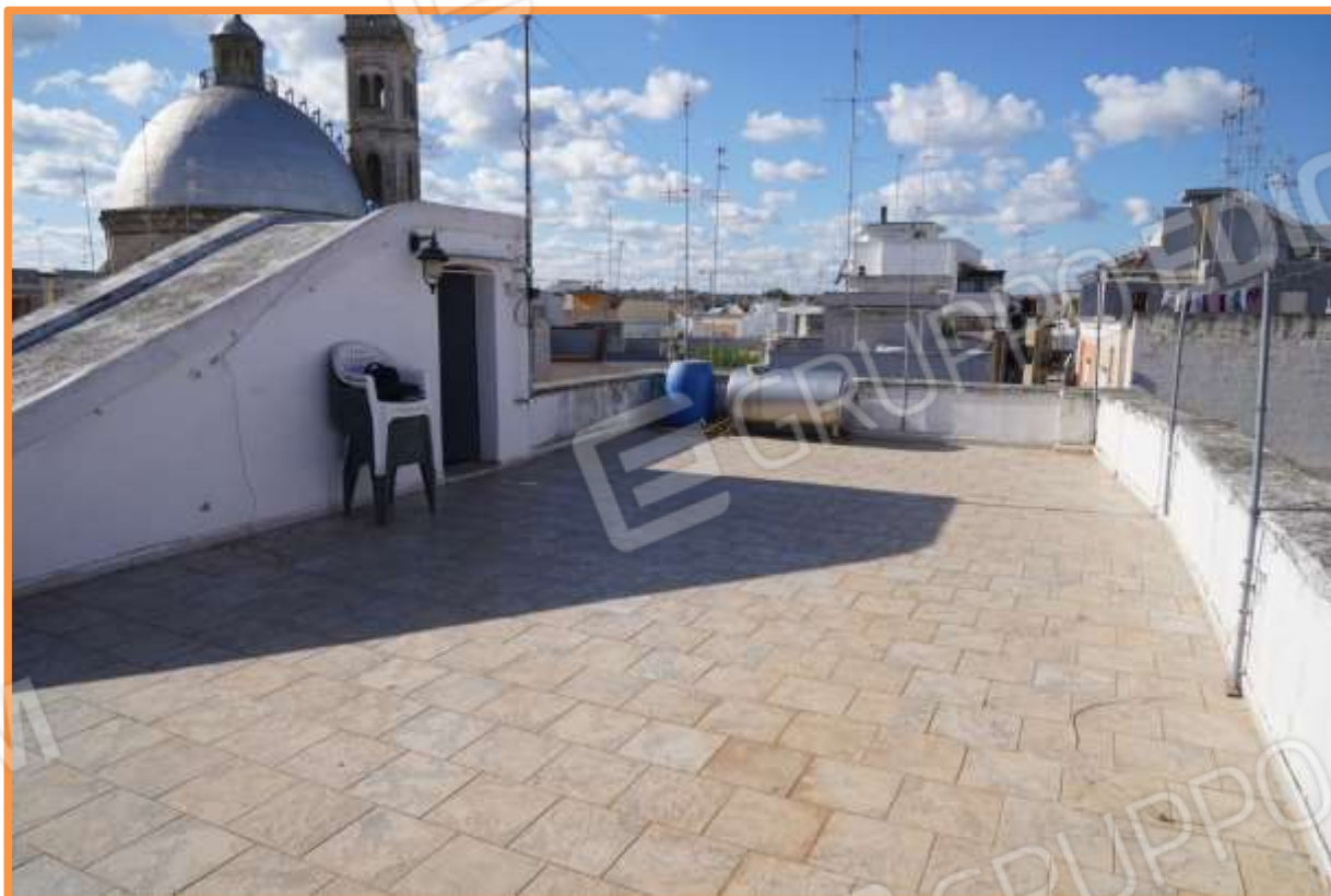
FOTO n° 23. Lastrico solare Vista verso la direzione ovest.
