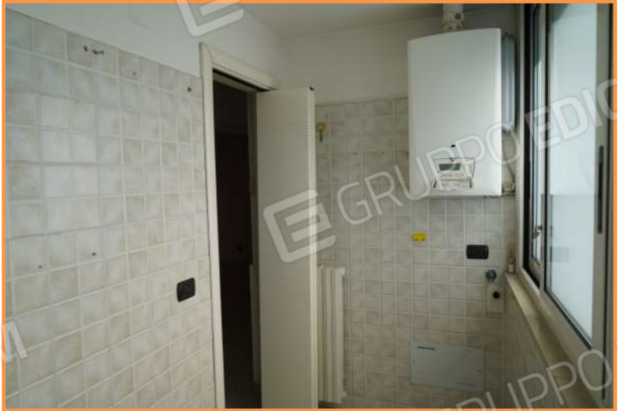
FOTO n° 15. Come foto n° 14. Vista verso la direzione est.
