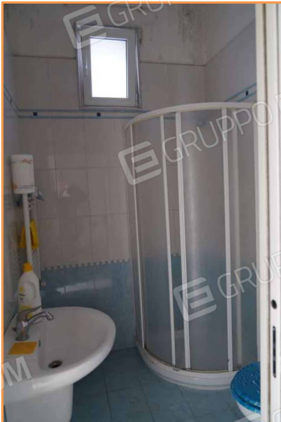
FOTO n° 13. Vano bagno. Vista verso la direzione ovest.
