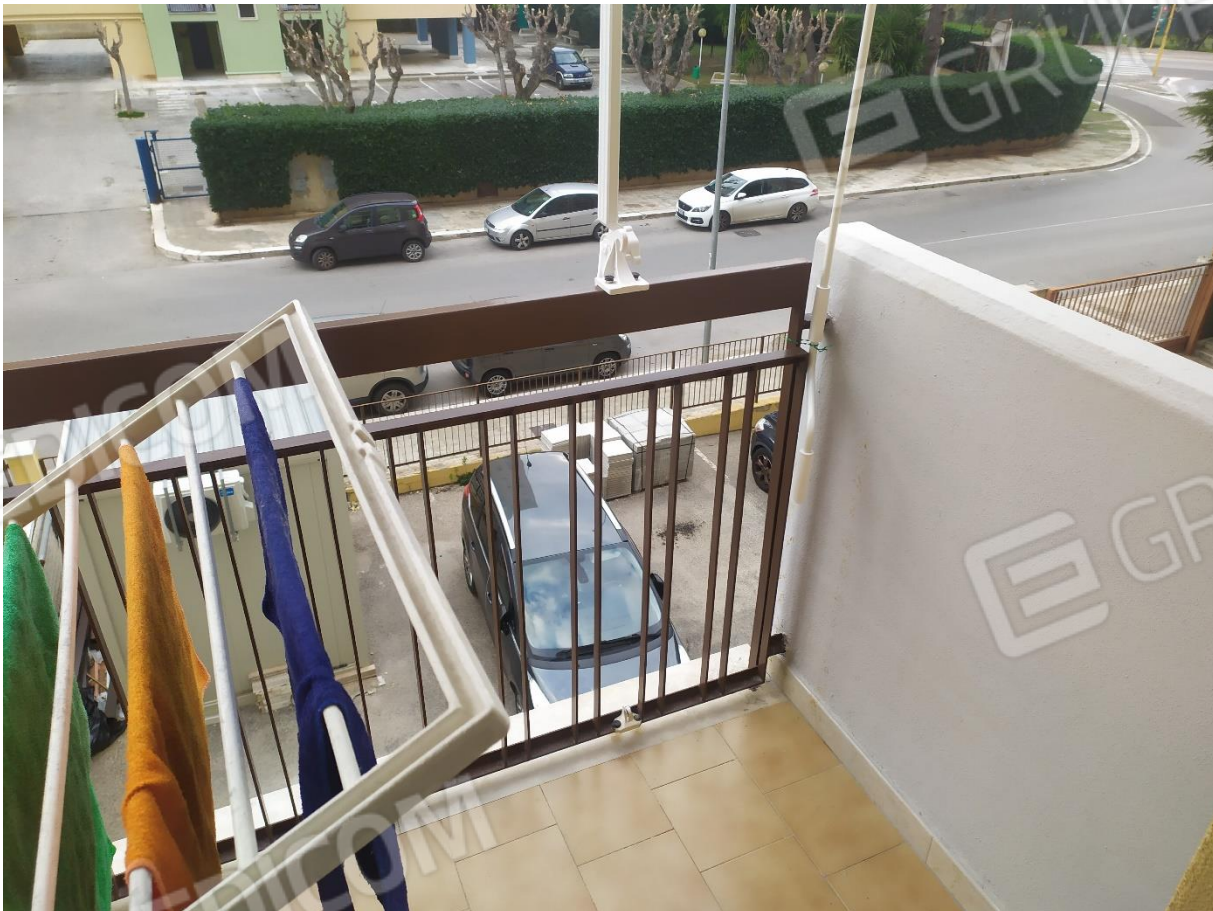
Foto n. 8: Balcone lato cameretta
