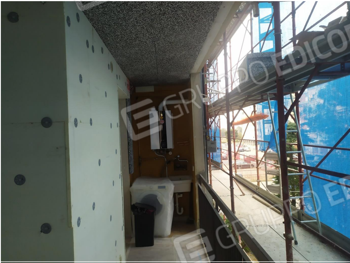
Foto n. 7: Balcone lato cucina-soggiorno
