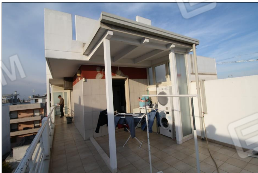
FOTO N.8 TERRAZZO SCOPERTO SUD E BALCONE OVEST
