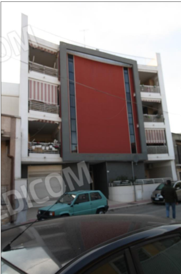
FOTO N.1 PROSPETTO SU VIA XXIV MAGGIO
