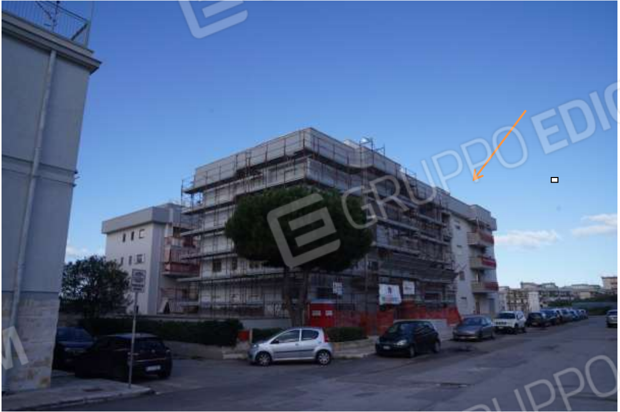
FOTO n° 1. Monopoli. Edificio con accesso dal civico 8 di via G. Antonelli. L'unità immobiliare staggita costituisce il lastrico solare di copertura dell'edificio condominiale pluripiano visibile in secondo piano.
