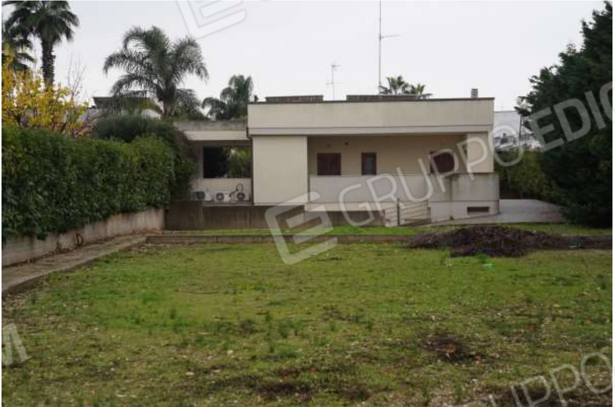
FOTO n° 7. Prospetto interno della costruzione, rivolto a nord. A sinistra è visibile il portico e a destra la pavimentazione carrabile che immette al parcheggio interrato.
