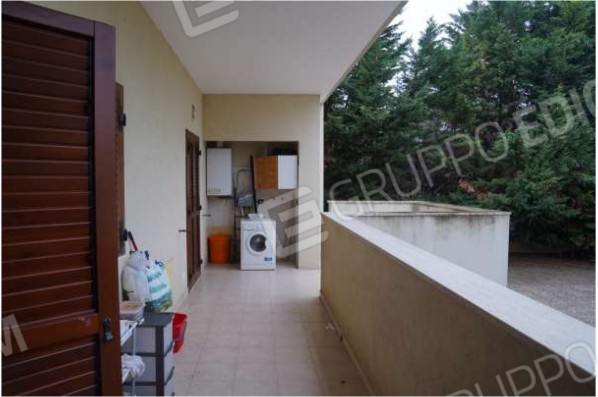
FOTO n° 17. Come foto n° 16. Vista verso la direzione ovest.
