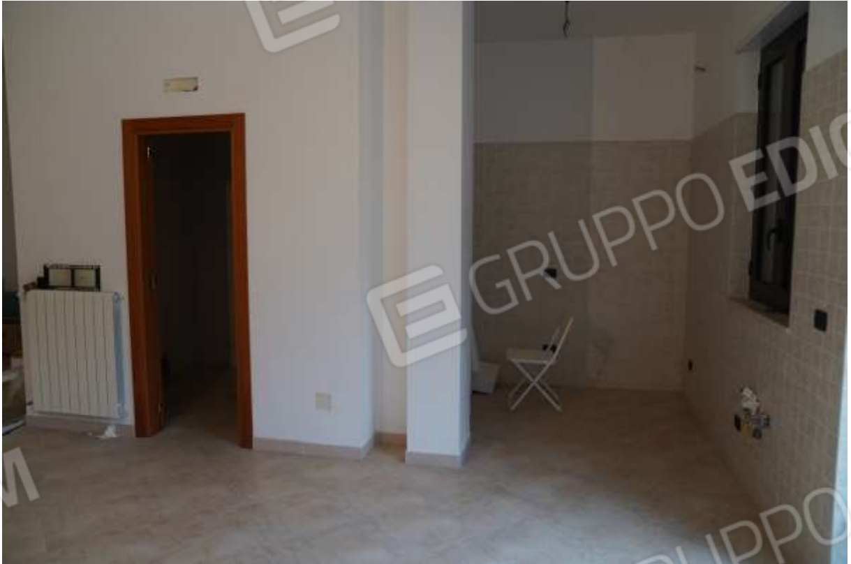
FOTO n° 28. Come foto n° 27. Vista verso la direzione ovest. Alla sinistra è visibile l'accesso al vano bagno.
