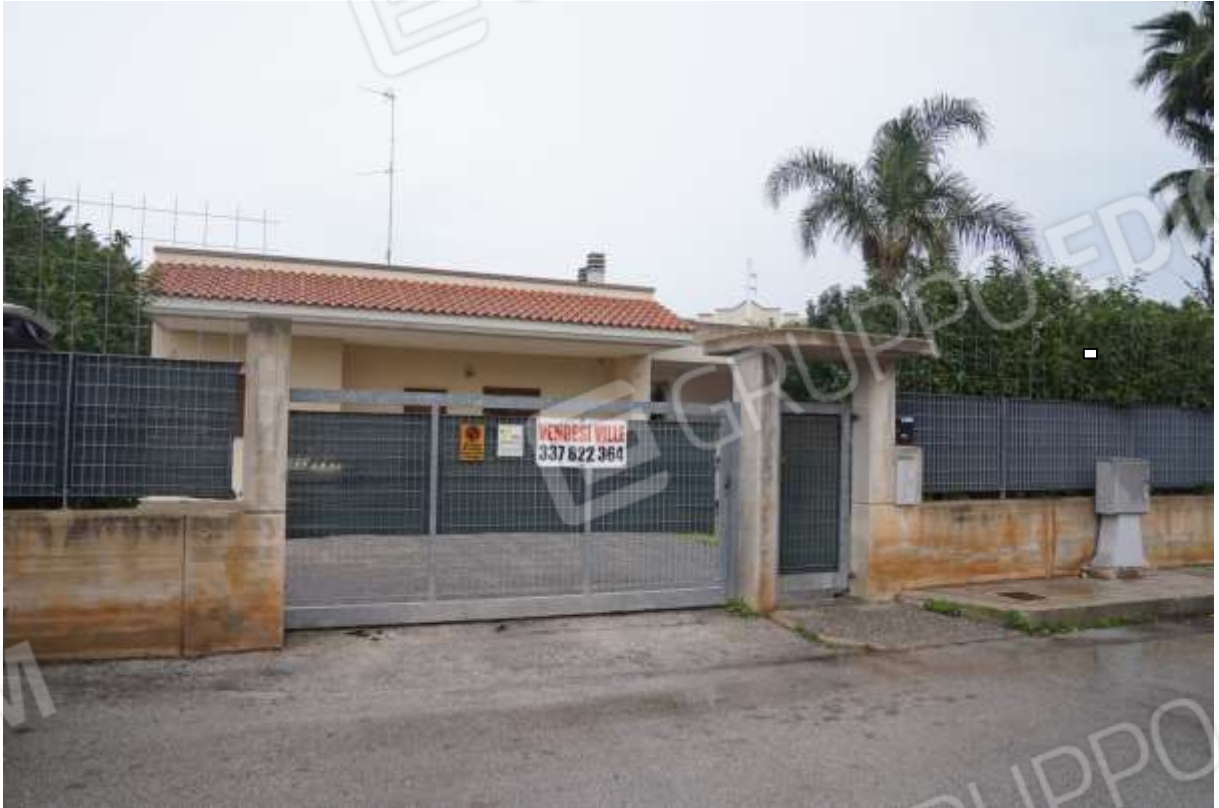
FOTO n° 1. Noicattaro. Via Scizze civico 19. Vista verso la direzione nord-est dell'ingresso all'unità staggita.
