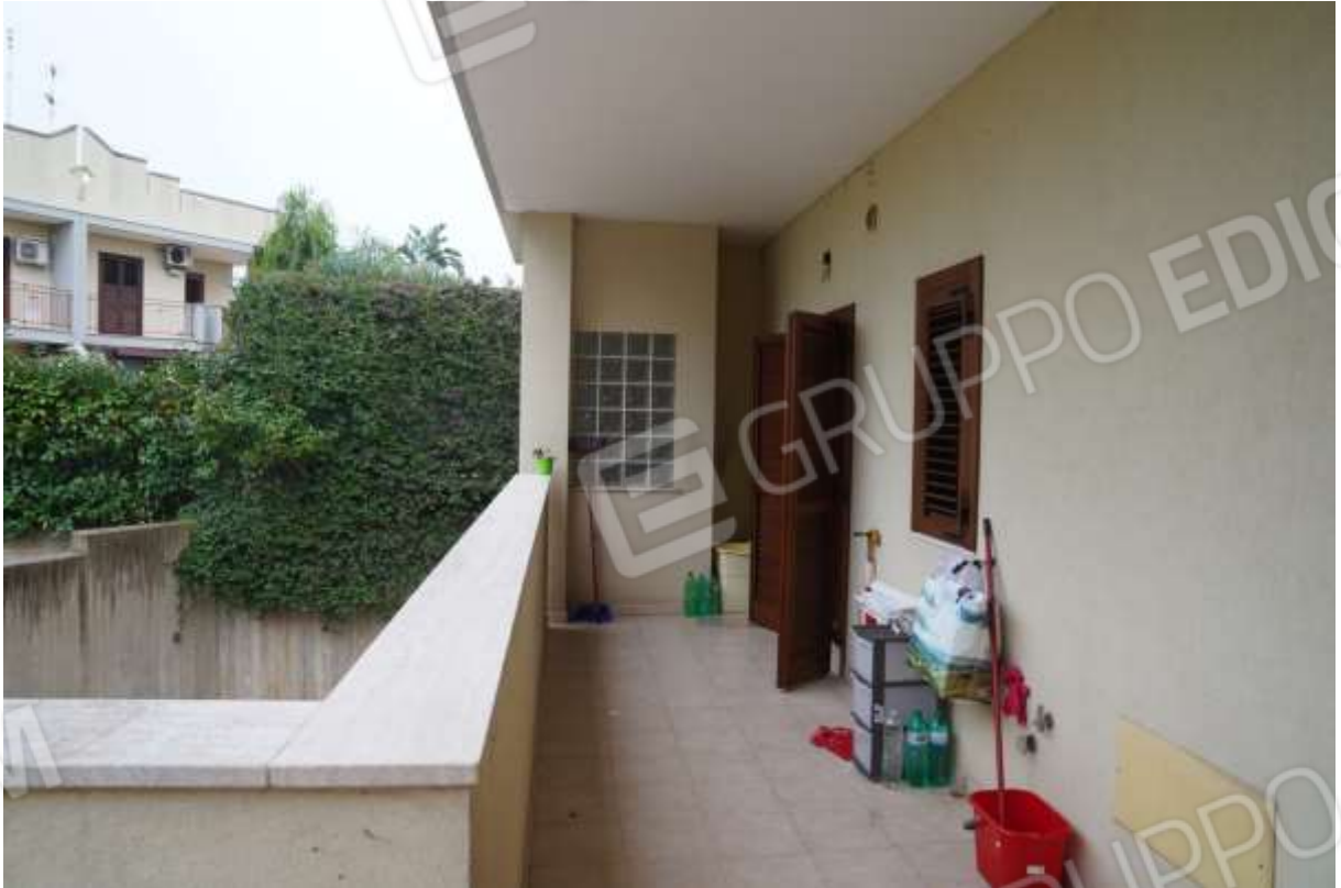
FOTO n° 16. Balcone su cui si affaccia il vano cucina-pranzo. Vista verso la direzione est. Il balcone a sua volta si affaccia sull'atrio interrato e sulla rampa scoperta di accesso al parcheggio interrato.
