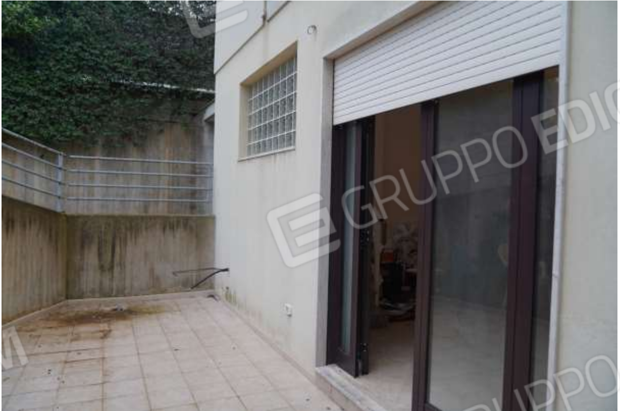
FOTO n° 32. Piano interrato. Atrio scoperto accessibile dal vano centrale. Vista verso la direzione est. Il muro di fondo con sovrastante ringhiera separa dalla rampa carrabile di accesso al parcheggio coperto.
