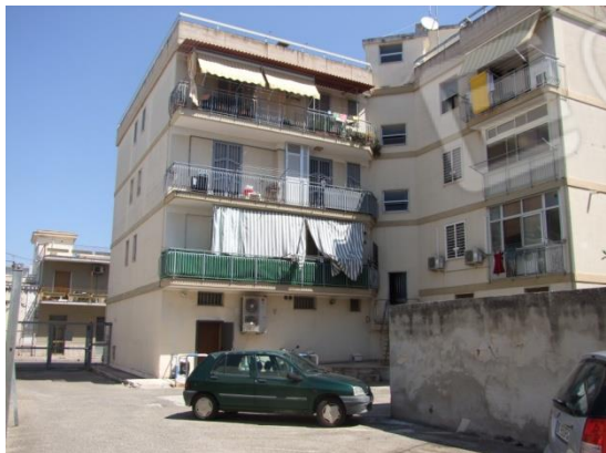
Foto 5 - Vista dei prospetti interni e posteriori dell'edificio
