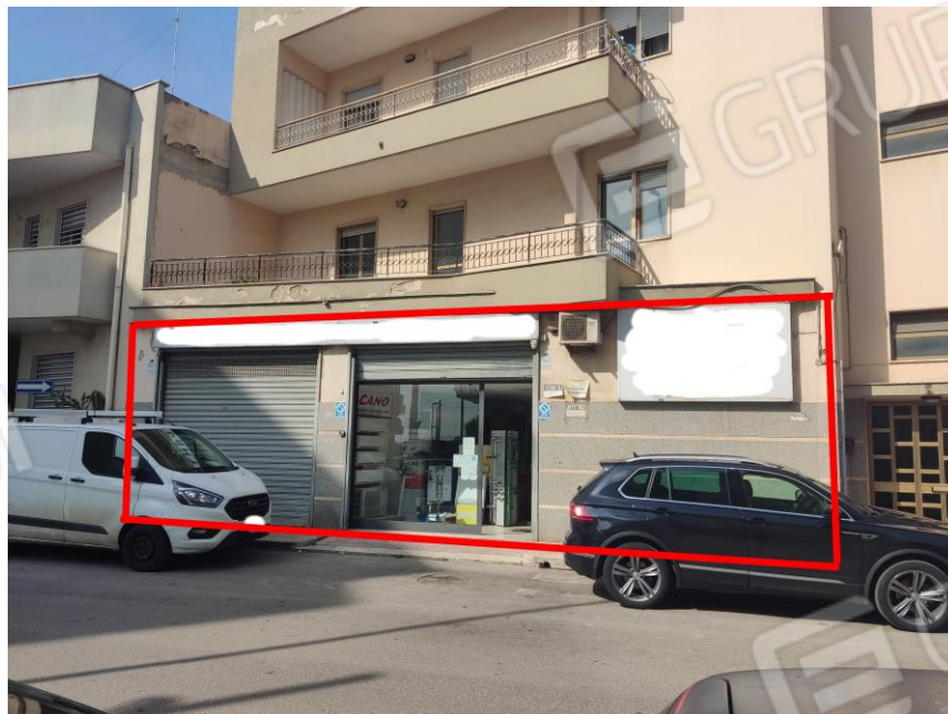
Piano terra: vista ingresso locale commerciale lotto n. 1 (Fig. 16, p.lla. 977, sub. 8)
