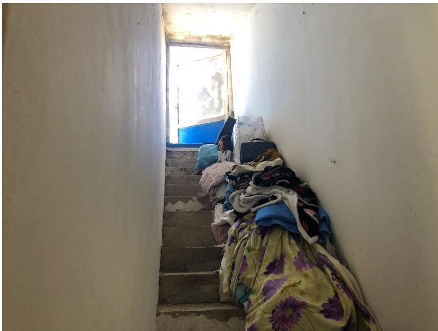
Foto n. 22: Vano scala 1°P verso terrazzo
