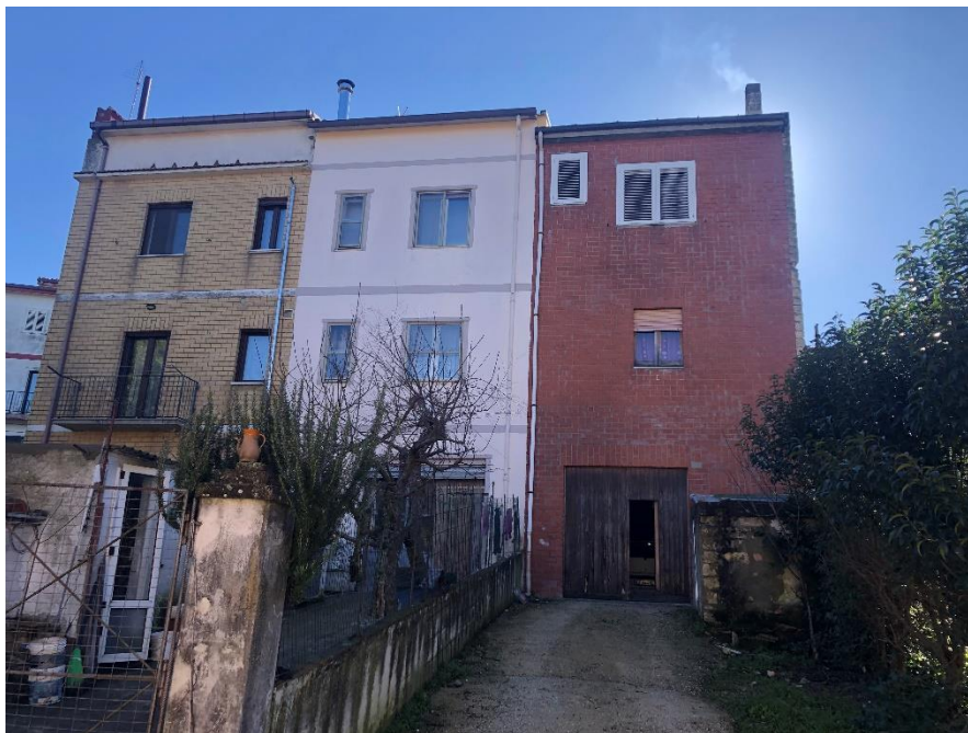
Foto n. 4: Prospetto posteriore bene oggetto di stima P. sottostrada, P.T. e 1° P
