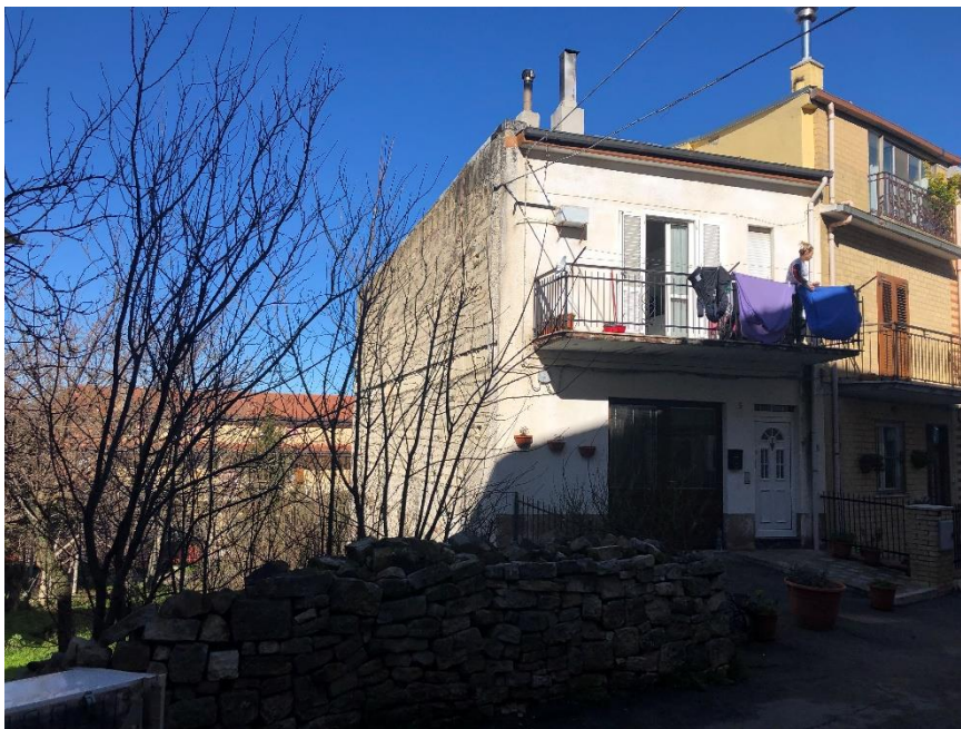
Foto n. 2: Prospetto principale bene oggetto di stima P.T. e 1° P – Via Santa Lucia I Traversa, 3
