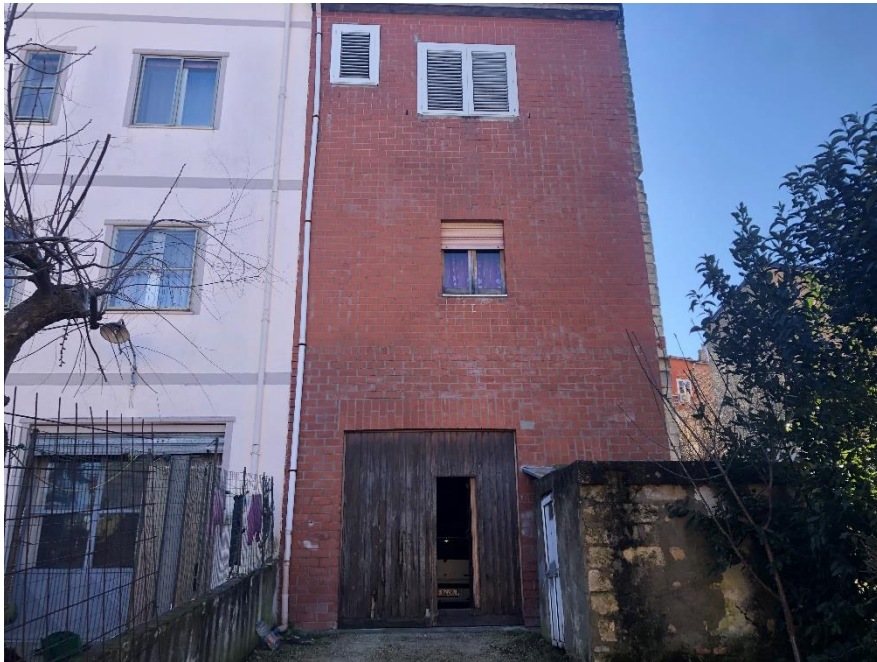
Foto n. 3: Prospetto posteriore bene oggetto di stima P. sottostrada, P.T. e 1° P
