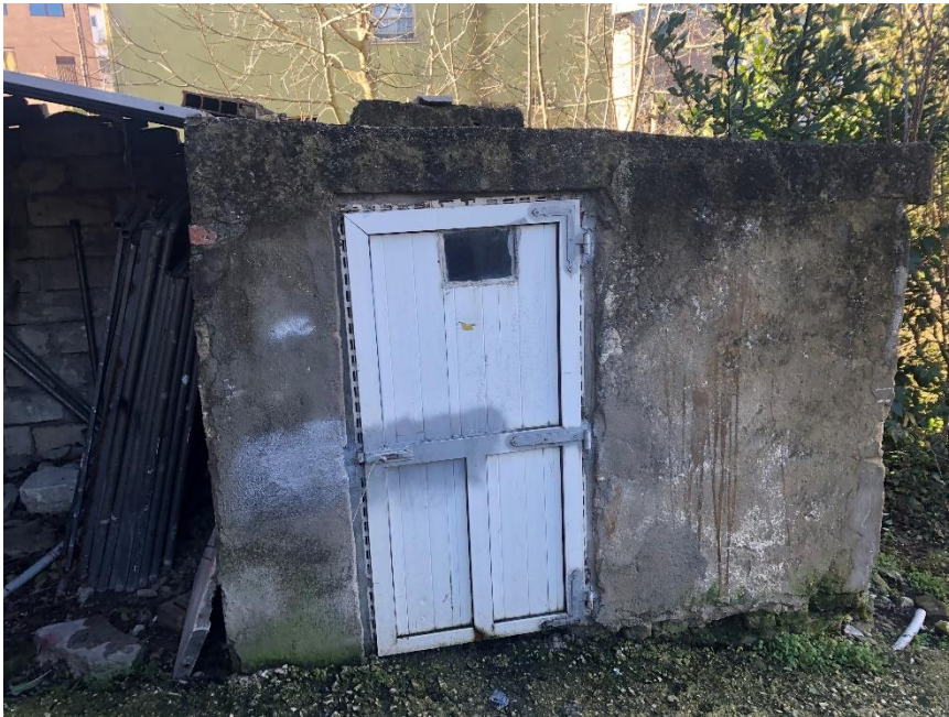
Foto n. 5: Locale Ripostiglio P. sottostrada
