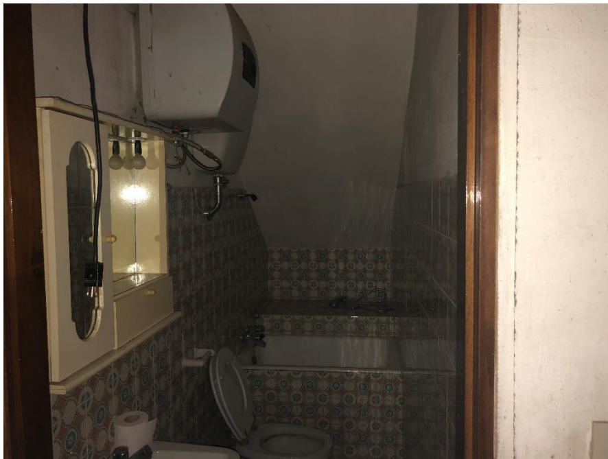
Foto n. 8: W.C. 1 Piano sottostrada – W.c.
