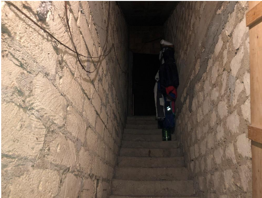
Foto n. 9: Vano Scala Piano sottostrada- Garage verso P.T.
