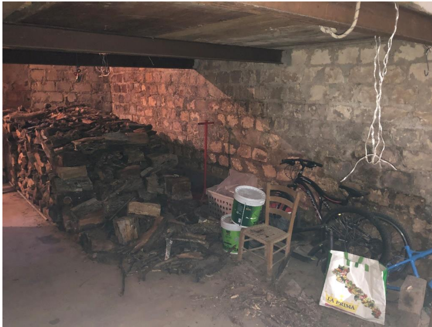
Foto n. 7: Piano sottostrada - Garage
