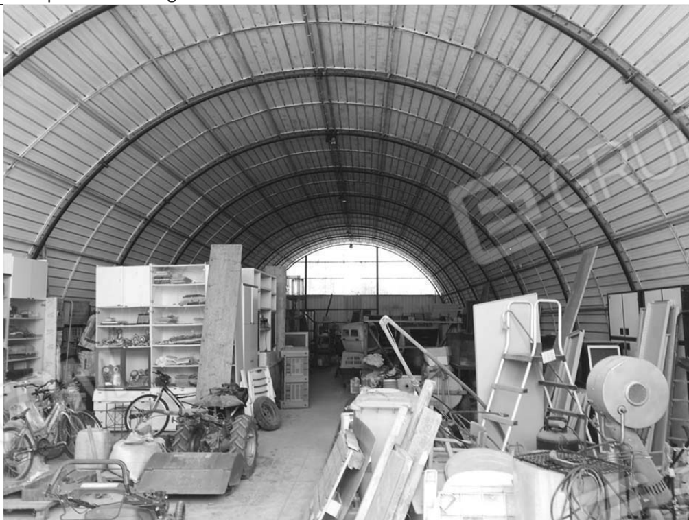
Fotografia 25 Interno capannone uso agricolo
