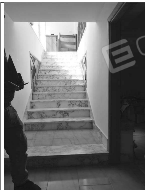
Fotografia 12 Scale di collegamento con il piano interrato
