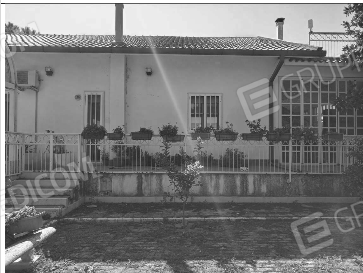
Fotografia 11 Prospetto Nord – balcone
