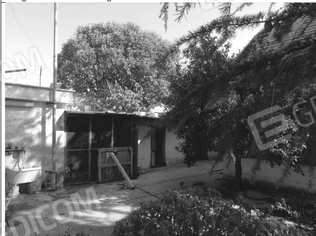
Fotografia 27 Manufatti lungo il confine Nord
