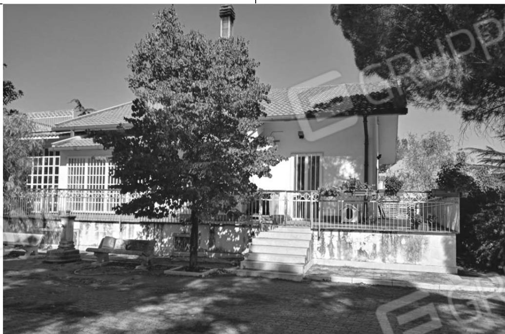
Fotografia 9 Prospetto Sud - balcone
