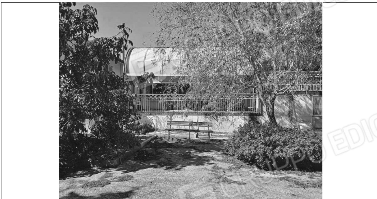
Fotografia 19 terrazzo a livelli sfalsato che copre la rampa di accesso al garage
