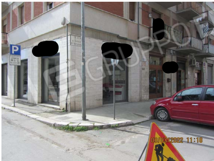
FOTO N° 84: VISTA GENERALE DEL FRONTE PROSPETTICO IN CORRISPONDENZA DELL'ANGOLO STRADALE FRA P.ZZA MEDAGLIE D'ORO E VIA PESTALOZZI.
