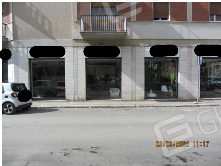
FOTO N° 83: VISTA GENERALE DEL FRONTE PROSPETTICO DELLE VETRINE PROSPICIENTI SU P.ZZA MEDAGLIE D'ORO DEL LOCALE COMMERCIALE FACENTE PARTE DEL 1° LOTTO DI FABBRICA.
