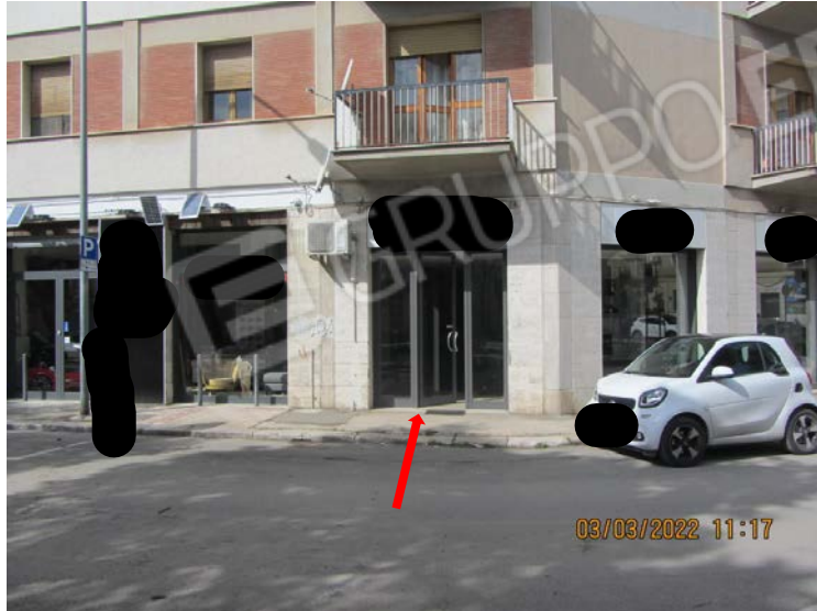
FOTO N° 82: VISTA GENERALE DEL FRONTE PROSPETTICO SU P.ZZA MEDAGLIE D'ORO DEL LOCALE COMMERCIALE FACENTE PARTE DEL 1° LOTTO DI FABBRICA. LA FRECCIA ROSSA INDICA L'INGRESSO PRINCIPALE LOCALIZZATO AL CIVICO N° 4.
