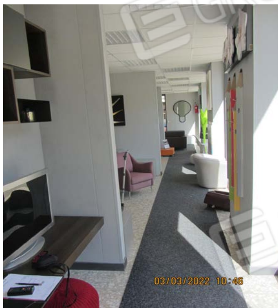
FOTO N° 85: VISTA GENERALE DELL'INTERNO CON SUDDIVISIONE DEGLI SPAZI INTERNI IN BOX MEDIANTE CARTONGESSO.
