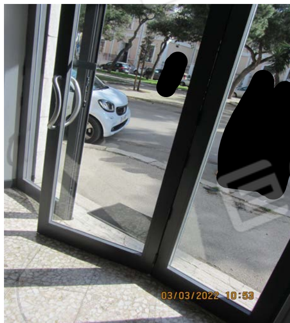
FOTO N° 95: VISTA PARTICOLAREGGIATA DELLA TIPOLOGIA DEGLI INFISSI ESTERNI RILEVATI AL SUO INTERNO.
