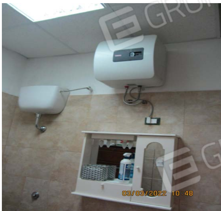
FOTO N° 97: ALTRA VISTA GENERALE DEL BAGNO INTERNO A SERVIZIO DEL LOCALE COMMERCIALE DI CUI ALLA PRECEDENTE FOTO OVE SI OSSERVA LA PRESENZA DI UN PICCOLO SCALDABAGNO ELETTRICO.
