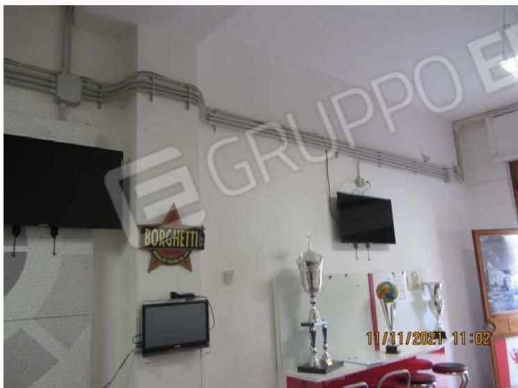
**FOTO N° 78:** VISTA GENERALE DELLA LINEA ELETTRICA A VISTA RILEVATA AL SUO INTERNO
