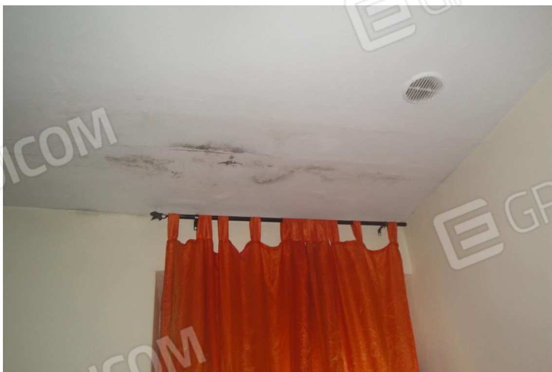
Foto 10: Unità abitativa posta in Casalnuovo Monterotaro ai piani T-1 di Via Galliano n. 9-11-13. Particolare macchie sul soffitto.
