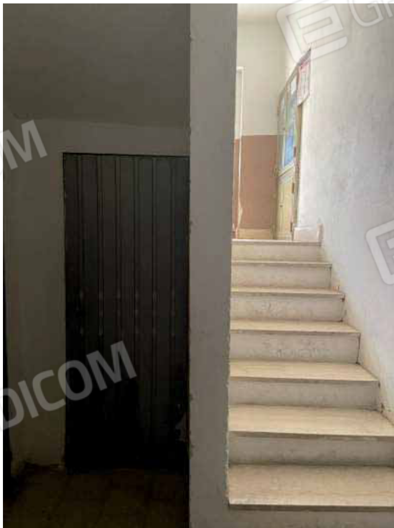
Foto 19) – Vista ingresso magazzino/sottoscala ( IMMOBILE B )
