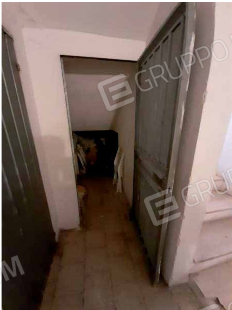
Foto 19.1) – Vista magazzino/sottoscala ( IMMOBILE B )
