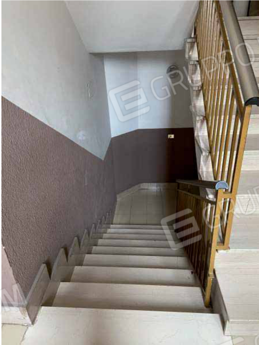
Foto 5) – Vista vano scala condominiale
