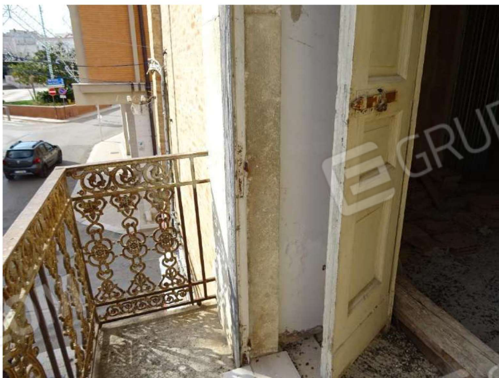
Foto n. 20 Particolare balcone prospiciente C.so Vittorio Veneto
