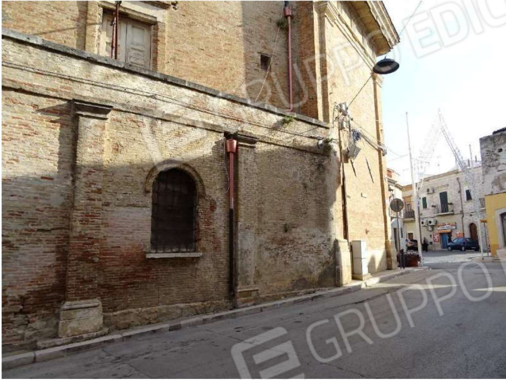
Foto n. 3 Prospetto su via Duca D'Aosta
