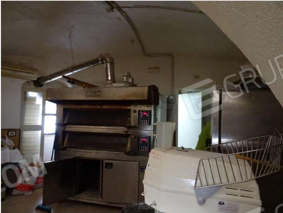
Foto n. 10 Interno zona laboratorio
