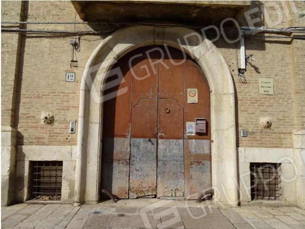
Foto n. 3 Portone di ingresso - C.so Vittorio Veneto n. 12
