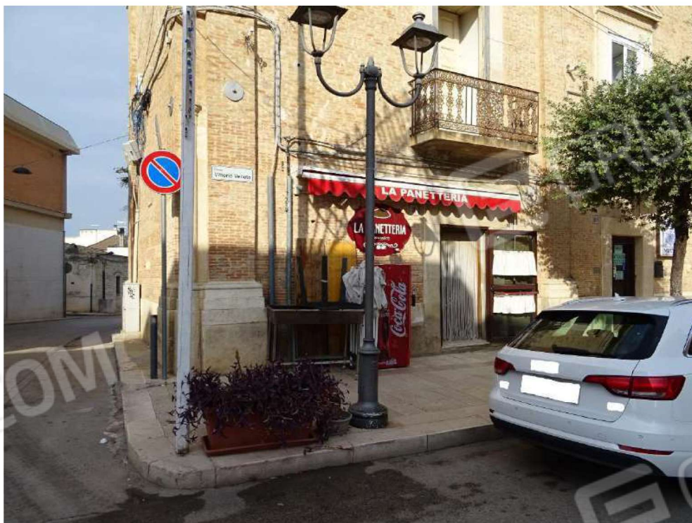
Foto n. 2 Foto Prospetto C.so Vittorio Veneto n. 8
