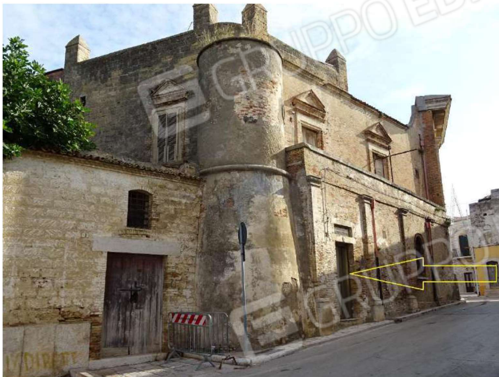
Foto n. 1 Foto Prospetto Via Duca D'Aosta n. 1
