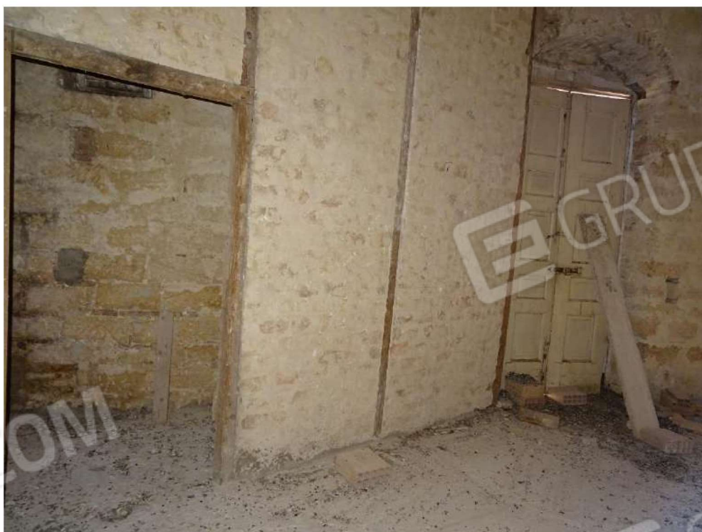
Foto n. 24 Interno cucina verso ripostiglio e infisso verso via Duca D'Aosta
