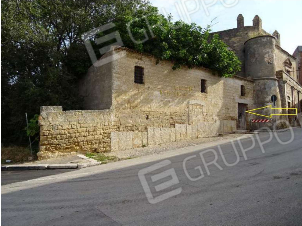
Foto n. 13 Foto ingresso Via Duca D'Aosta n.3
