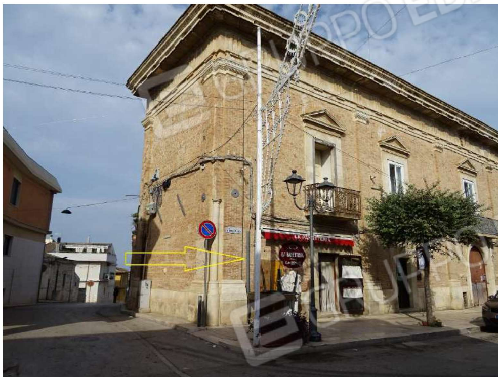
Foto n. 1 Foto Prospetto C.so Vittorio Veneto n. 8
