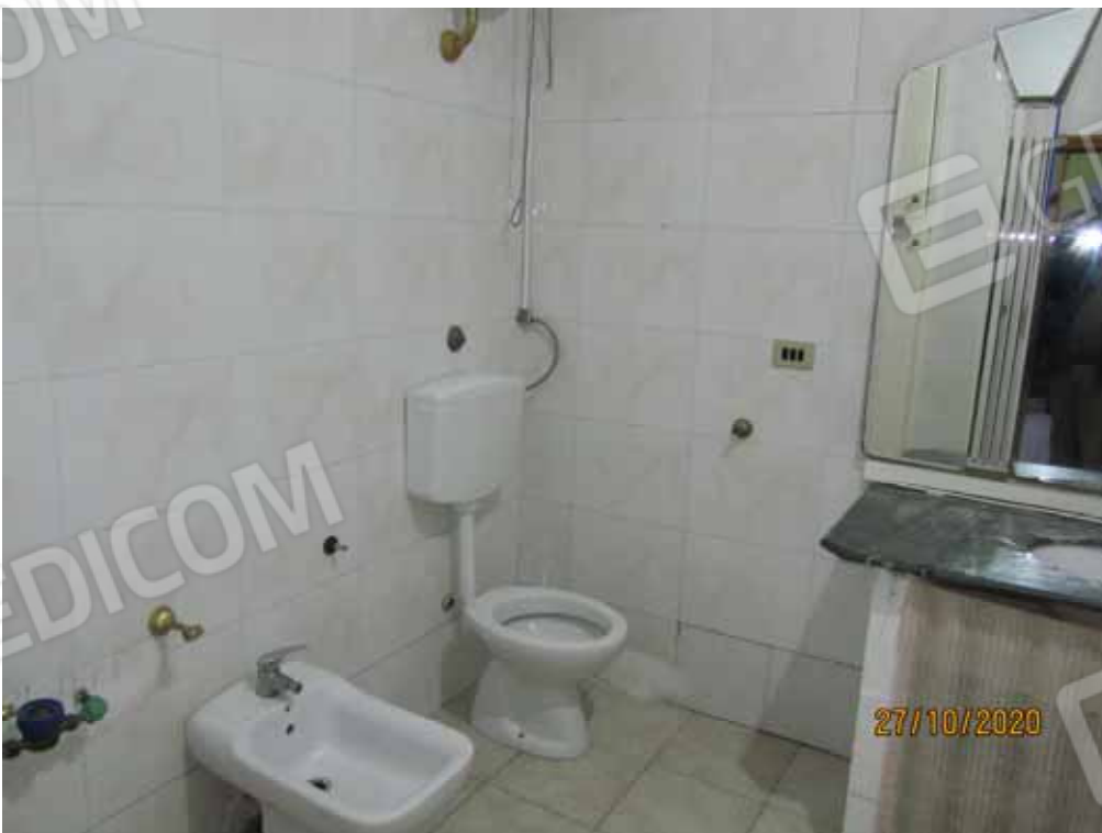
FOTO 8 – Bagno – particolare articoli sanitari.
