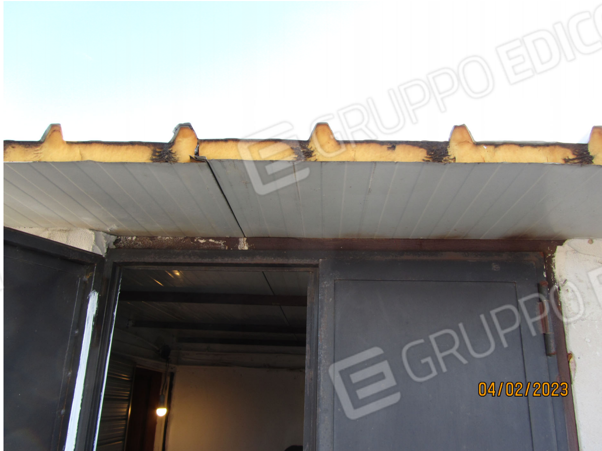
FOTO N. 21 – PARTICOLARE DELLA COPERTURA DEL VANO 2.
