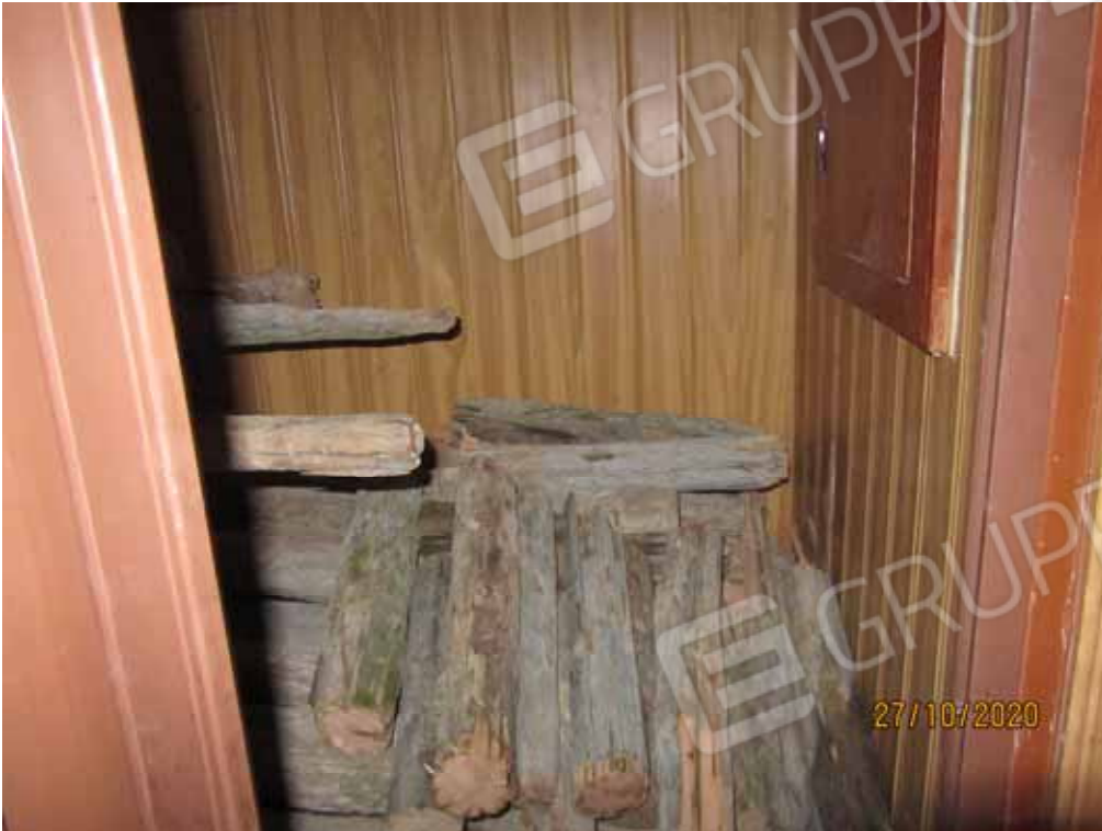
FOTO 3 – piccolo vano deposito al piano terra ricavato nella zona al di sotto della 2 a rampa di scale.
