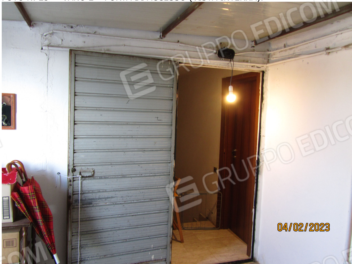
FOTO N. 23 – VANO 2 – PORTA DI ACCESSO (VISTA INTERNA).
