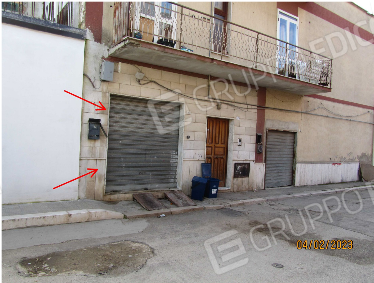
FOTO N. 1 – VEDUTA ESTERNA LOCALE DEPOSITO CIVICO N.4.
