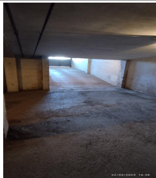
Foto 15. Discesa della rampa dei boxes
