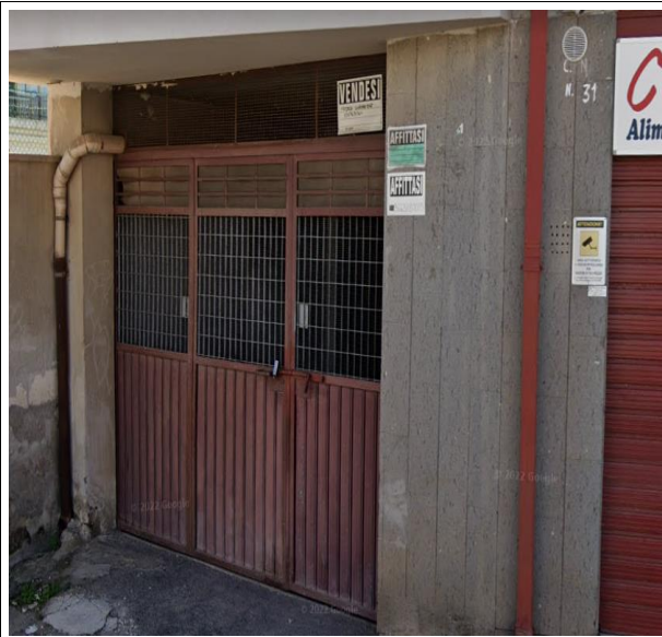
Foto 14. Vista ingresso rampa dei boxes
