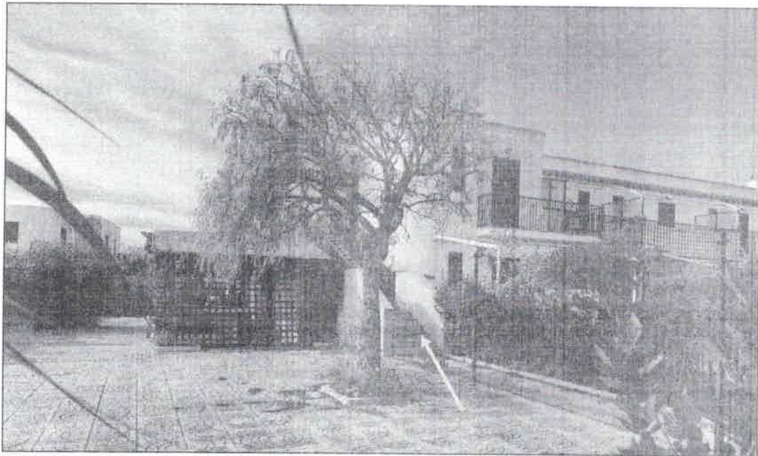
Figura 7 – Particolare scala accesso all'immobile al piano primo – Subalterno 13
