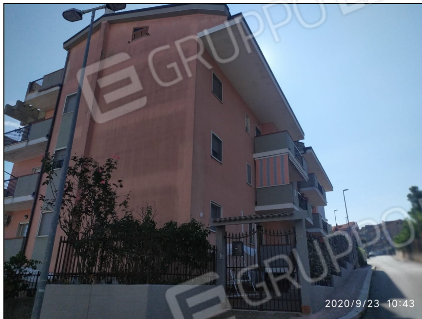
Foto 1: Vista prospetto esterno palazzina Via Roma angolo Via De Finis.
