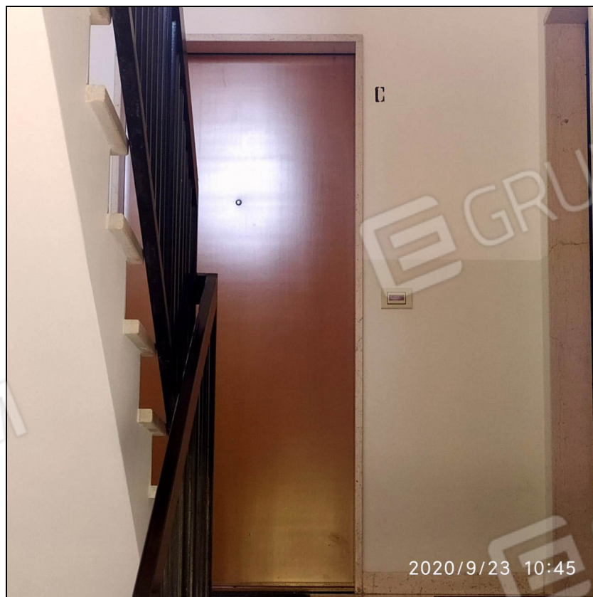
Foto 5: Vista portoncino di accesso all'appartamento contraddistinto dalla lettera "C".
