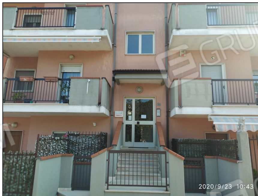
Foto 2: Vista prospetto esterno palazzina con accesso da Via Roma n. 11.
