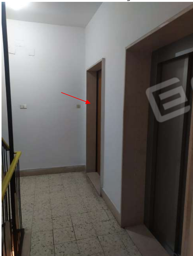
FOTO N.3 - Porta d'ingresso dell'abitazione.
