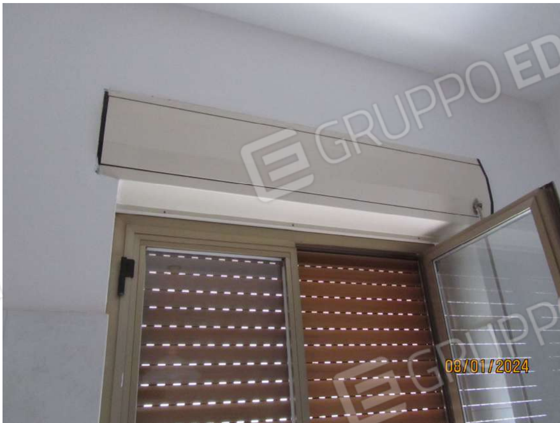
FOTO N.15 - Particolare infissi in anticorodal.
