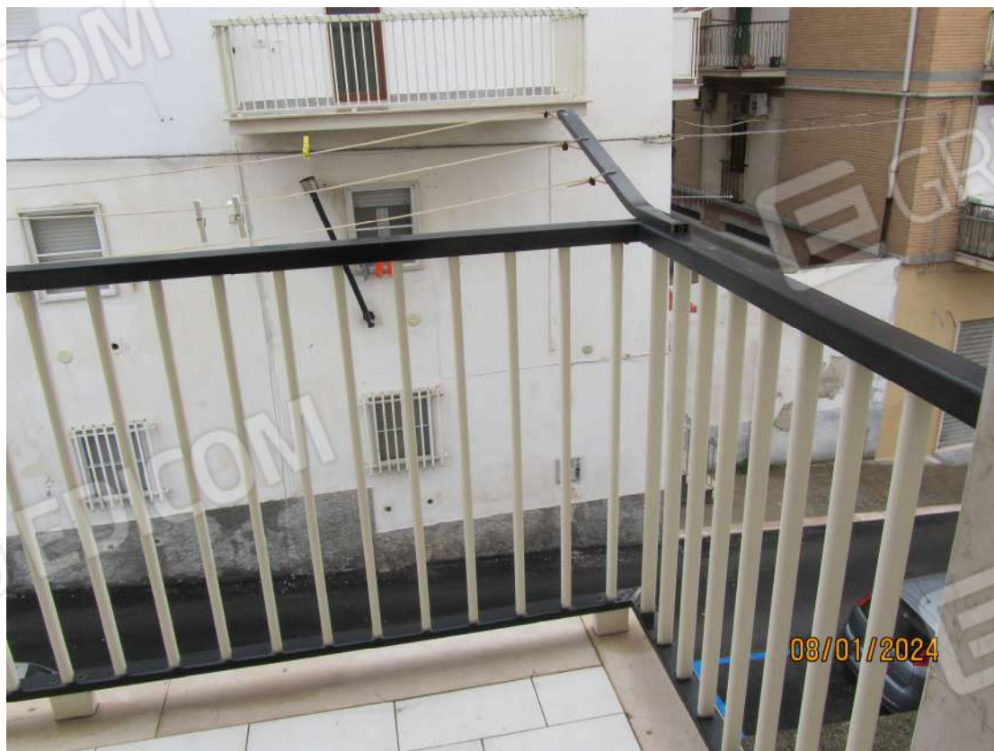
FOTO N.14 - Balcone su via Brindisi.
