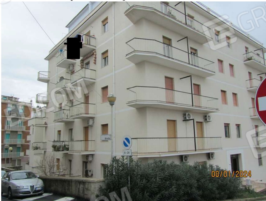
FOTO N.2 - Prospetto ad angolo tra via Brindisi e via Dalmazia.
