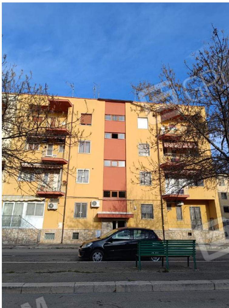
Foto C2 - LOTTO 1 - FABBRICATO IN VIA LUIGI OBERTJ N. 6 FOGGIA
