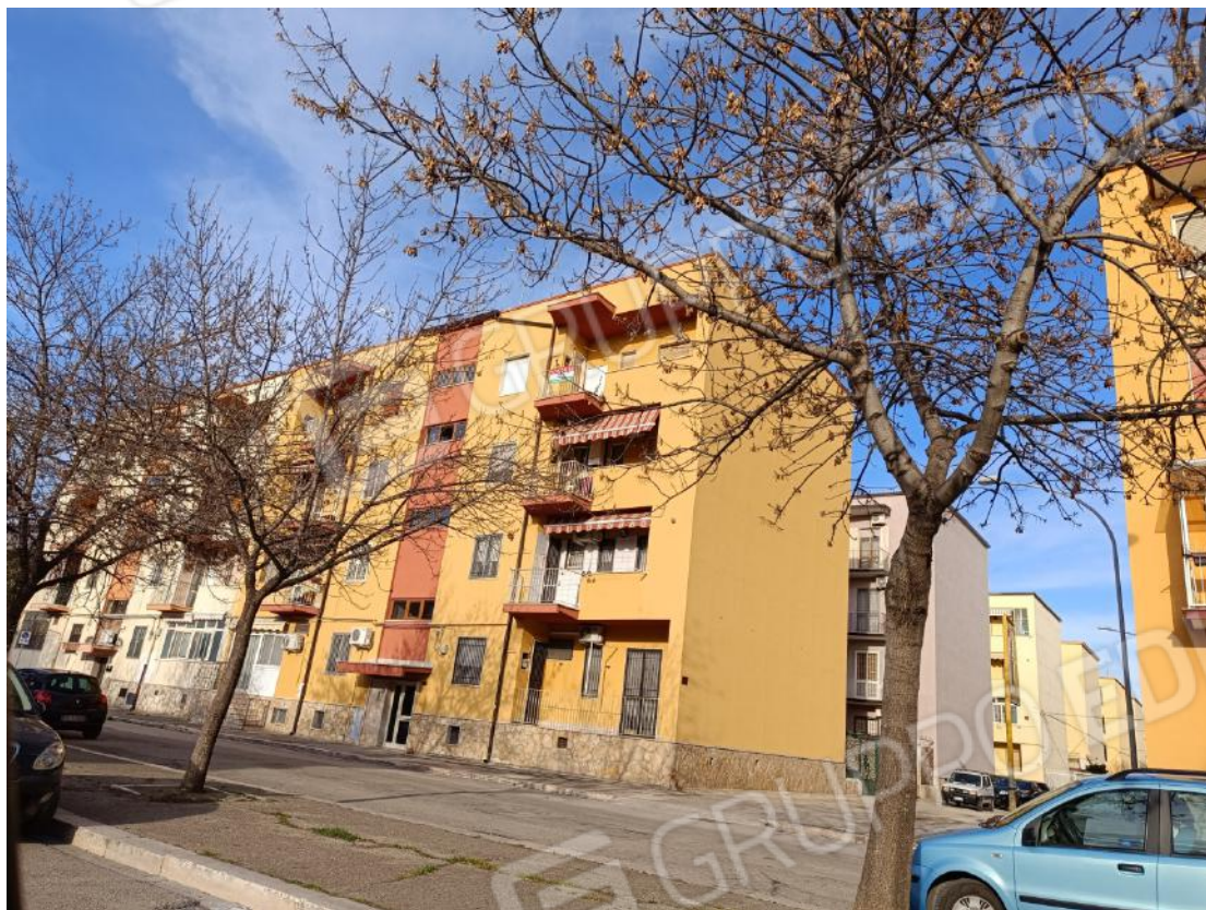
Foto C1 - LOTTO 1 - FABBRICATO VIA LUIGI OBERTJ N. 6 FOGGIA
