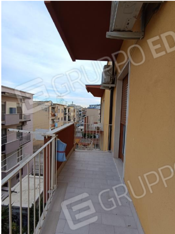
Foto C11 - LOTTO 1 - ABITAZIONE AL TERZO PIANO - BALCONE AD EST
