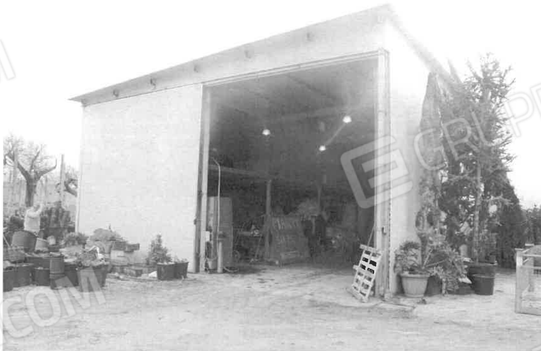
particolare del manufatto abusivo di proprietà dell'affittuario
