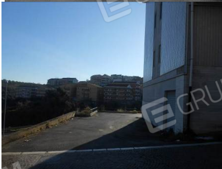
(c) Fotografie del locale box a pianterreno ubicato in via Fontane senza numero civico: serranda di accesso (a); ambiente interno (b); strada privata (c).
