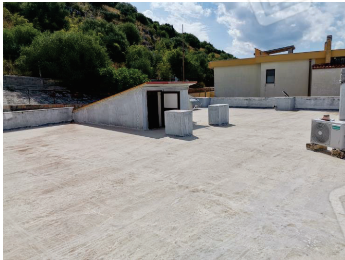
LOTTO 4 il lastrico solare sub 8
