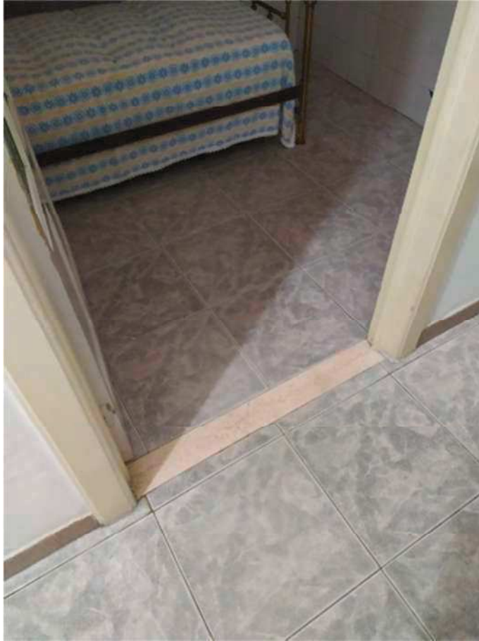
Foto 17 _ Particolare pavimentazione camera 3
