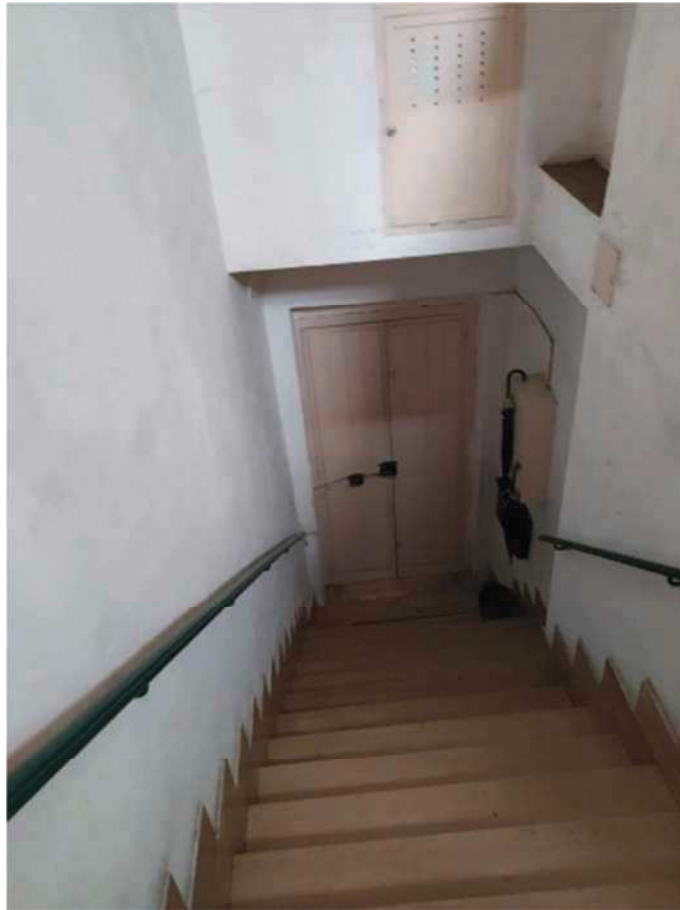
Foto 9 _ Prima rampa scalinata di accesso
