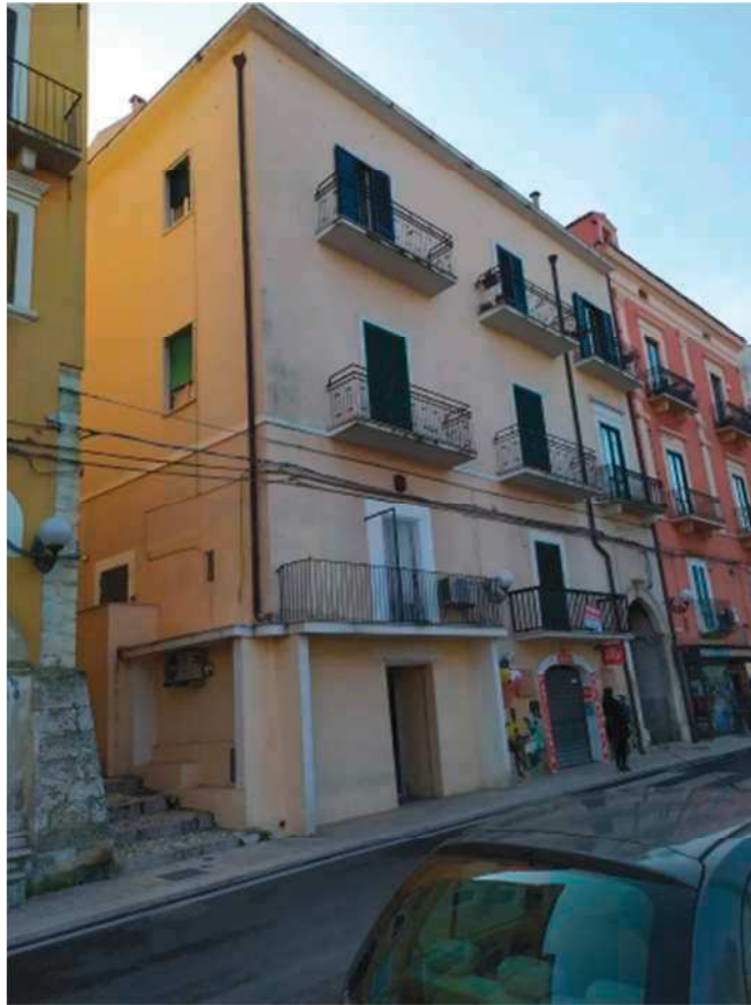
Foto 1 _ Facciata del Fabbricato condominiale su Corso Madonna della Libera
