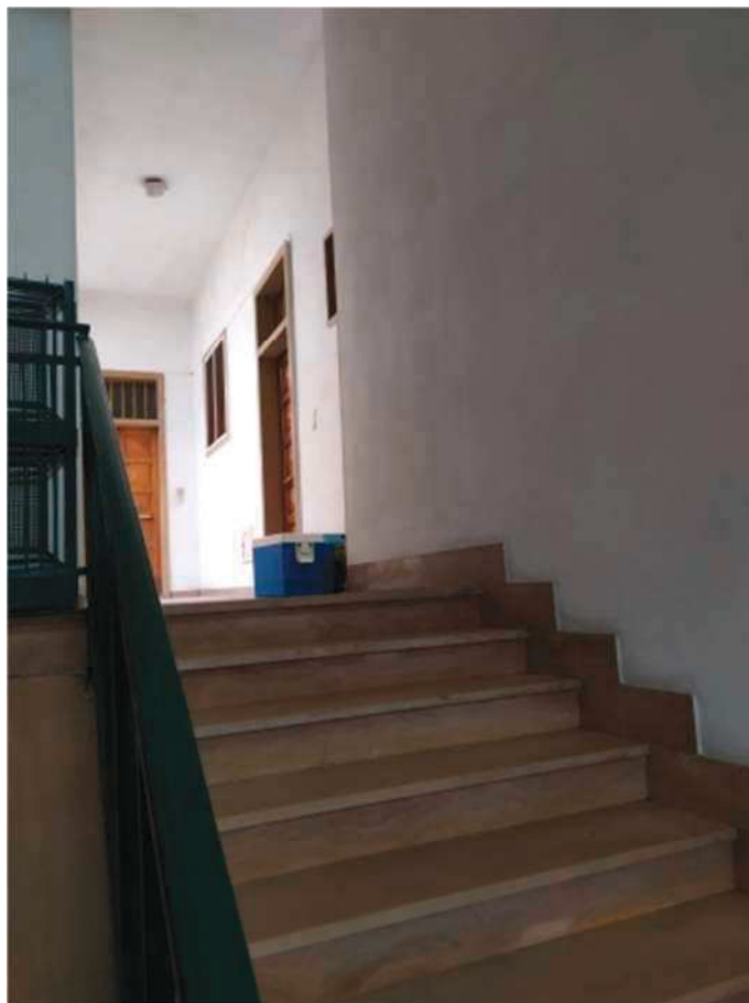
Foto 10 _ Rampa di arrivo al pianerottolo
