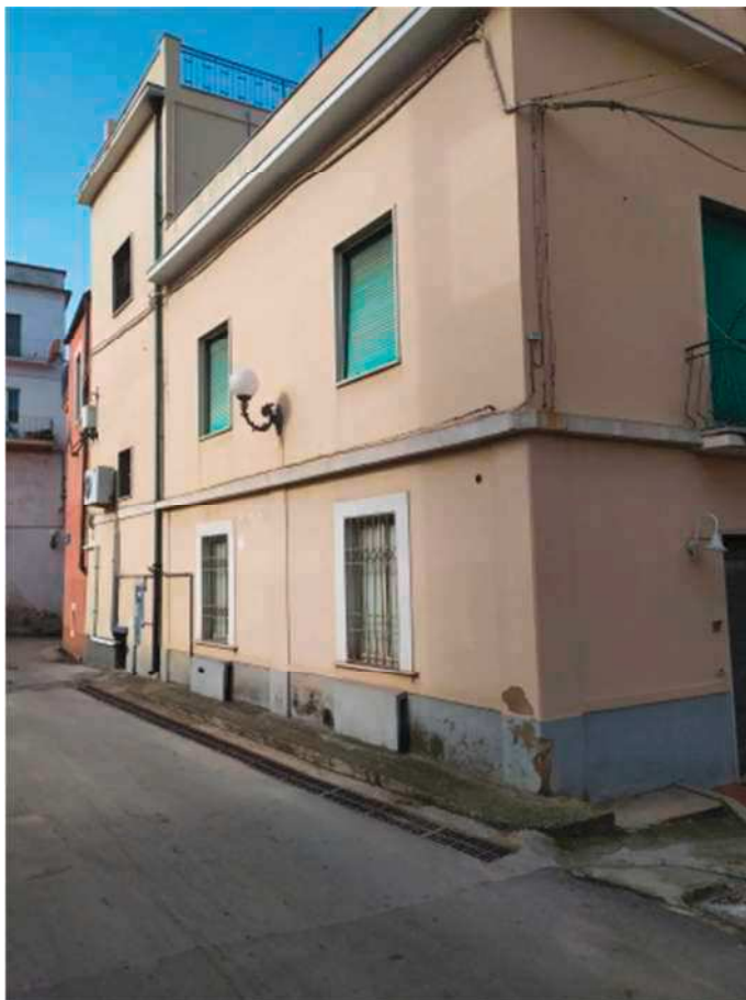
Foto 4 _ Vista dell'appartamento (1° piano) da Corso Ruggero Bonghi
