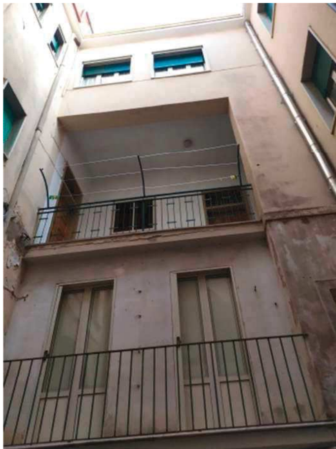
Foto 8 _ Facciata sul cortile interno. Accesso all'appartamento da ballatoio
