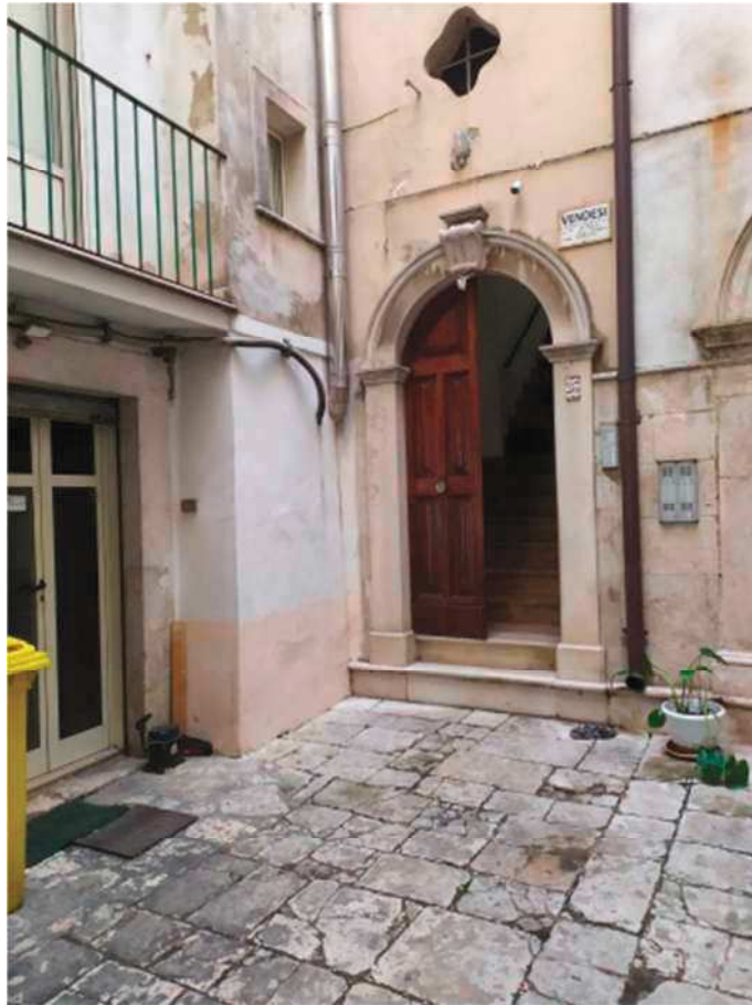
Foto 7 _ Cortile interno e portoncino di accesso all'appartamento
