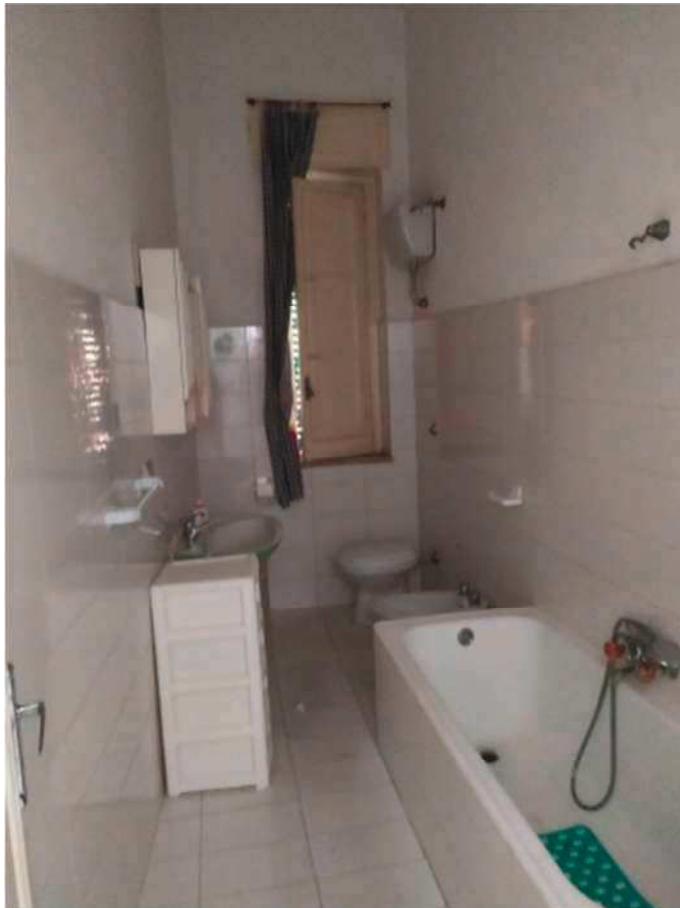
Foto 18 _ Bagno e particolare pavimentazione e rivestimento pareti
