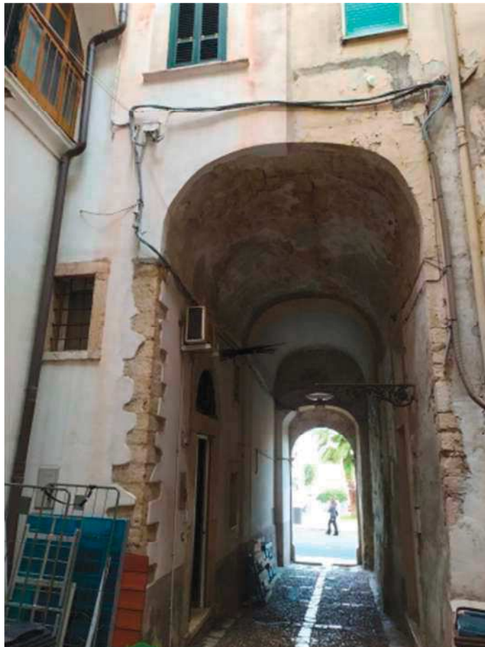
Foto 6 _ Accesso al Fabbricato condominiale con vista dal cortile interno
