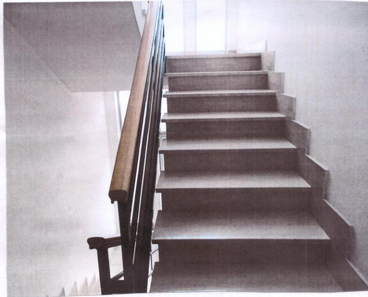
Foto n. 3 – Particolare della rampa scala condominiale
