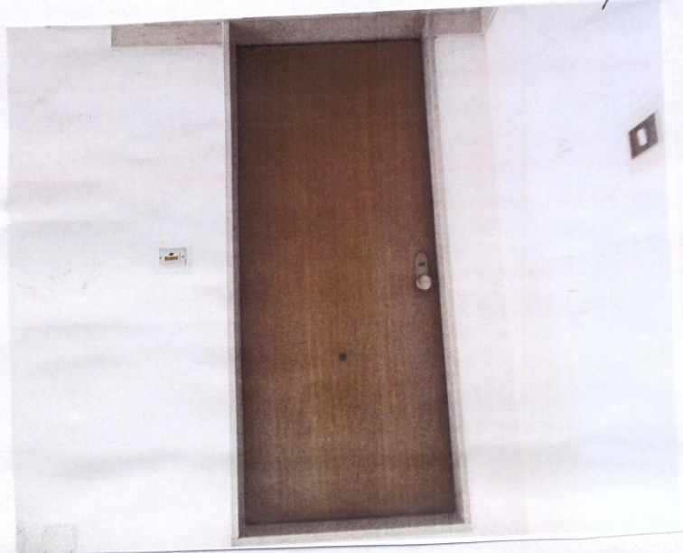
Foto n. 4 – Particolare porta accesso all'immobile Staggito – terzo piano – scala B
