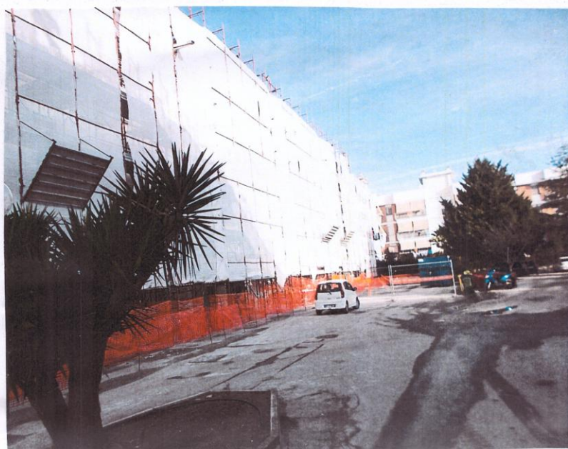
Foto n. 1 - stabile condominiale di via Pietro Nenni n. 11 sottoposto a lavori di ammodernamento – Ecobonus 110%
